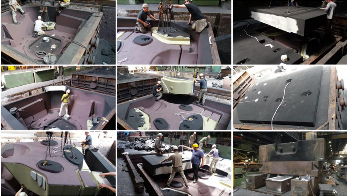
Abbildung 2.8: Die Herstellung des WKA-Maschinenträgers ist durch kernintensives Formbauen gekennzeichnet; durch zusätzlich integrierte Forminstrumentierung hat sich die Arbeitsphase auf drei Tage ausgedehnt
