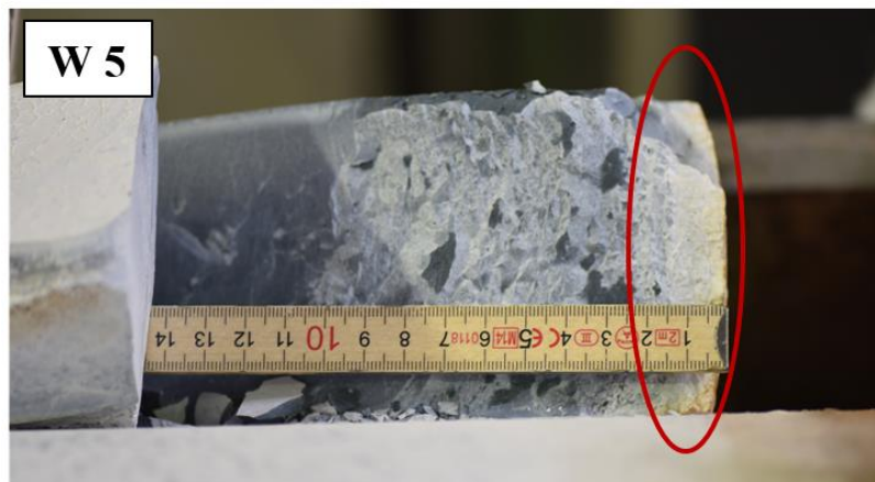
Abbildung II-55: Entmischungen am oberen Abschluss des Grout-Körpers
