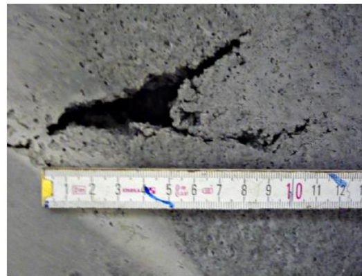
(a) Lufteinschluss (weiße Elipse) (b) Fehlstelle nach dem Ausschalen
