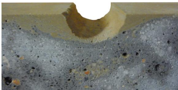
Abbildung II-62: Ablagerung der Vorlaufmischung im Bereich der oberen Schubrippe; Material B, w/f = max, Umgebungsbedingung: trocken (Werner, 2017)
