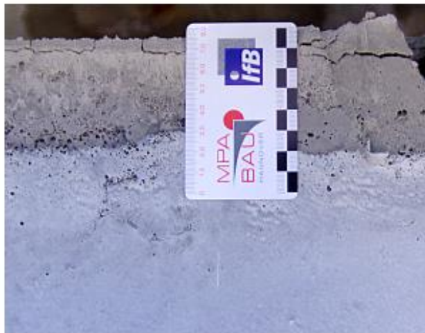
(a) „Schlammschicht“ im oberen Bereich
