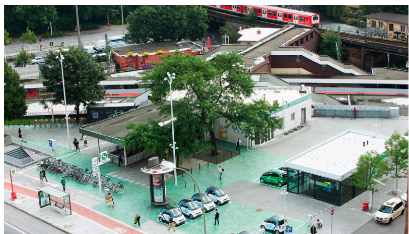
Abbildung 39: switchh-punkt am Berliner Tor © Hamburger Hochbahn
