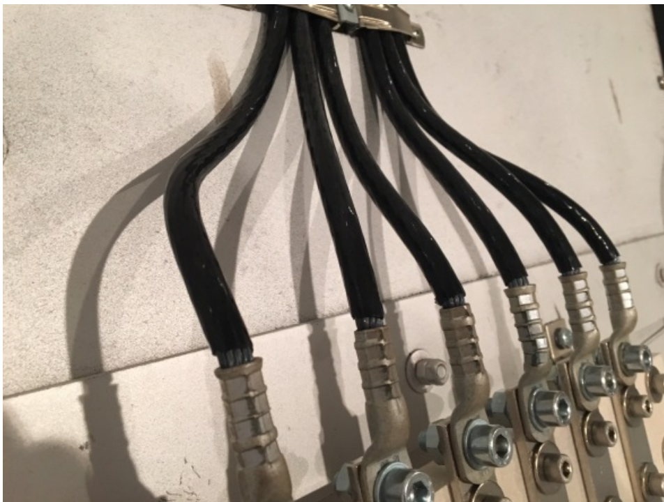
Abbildung 65: Installierter Klemmbock mit Spezialkabel [4]
