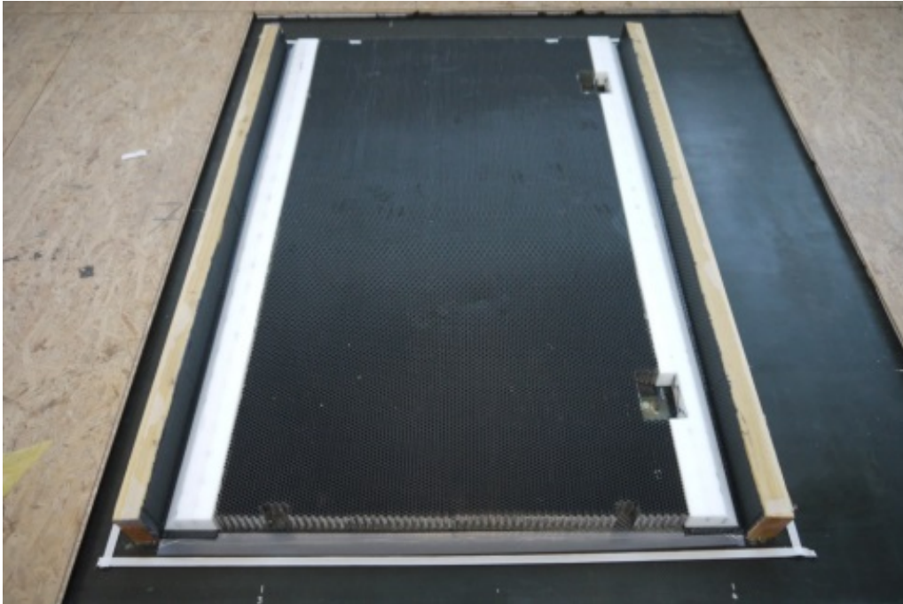
Abbildung 44: Einbringung des durchlüfteten Wabenkerns [4]
