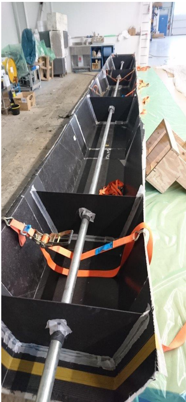
Abbildung 59: Zentrale Hut-Profil Versteifung im Bau [4]
