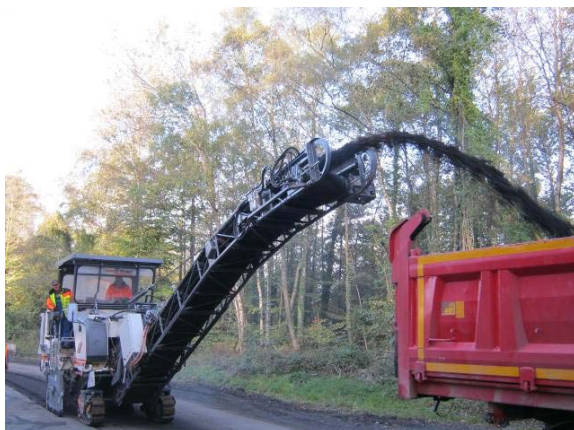
Bild 168: Baustellenerprobung des Bandantriebs
