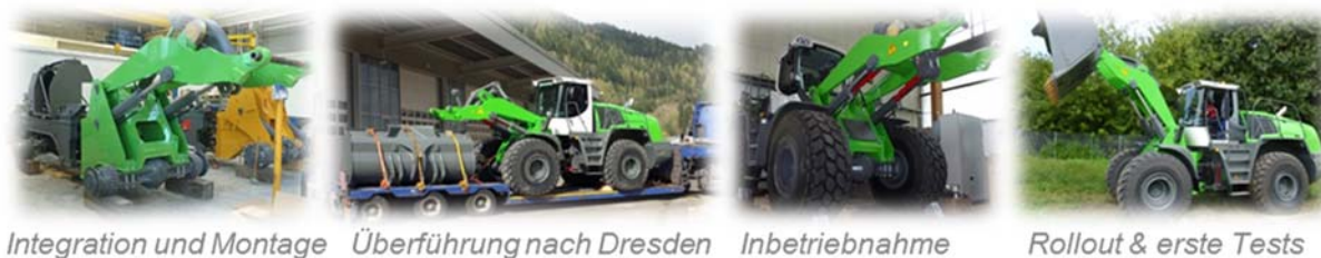
Bild 221: Aufbau und Inbetriebnahme
