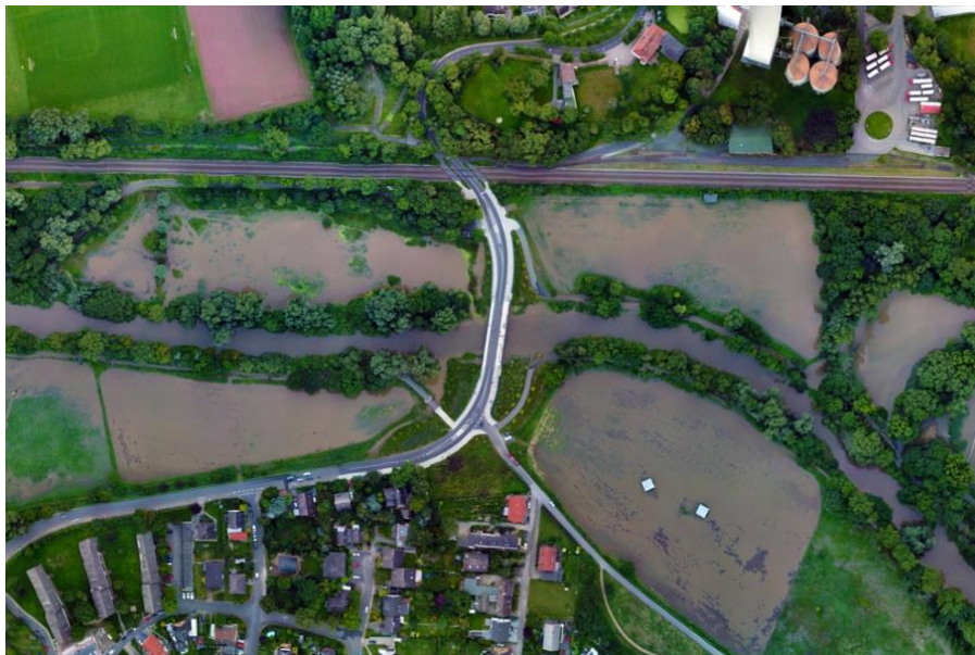
Abbildung 6-112: Ausschnitt aus Orthofoto überfluteter Bereiche, Julihochwasser 2017 in Braunschweig
