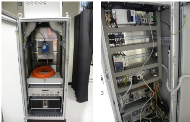
Abbildung 78 Prozessvisualisierungssystem für Installation auf der dritten Portalbrücke
