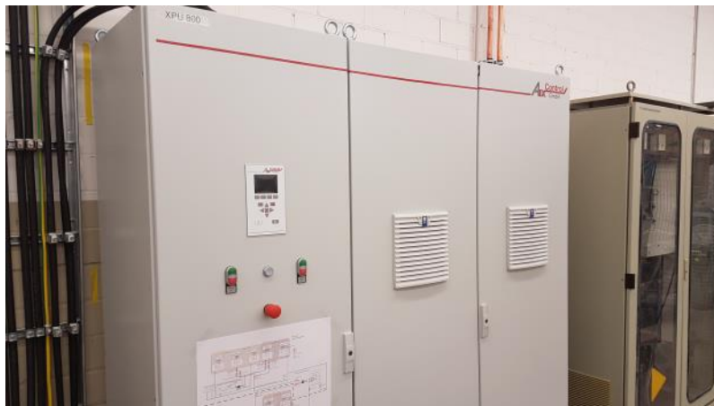
Abbildung 76: Galvanisch getrennter 800 V DC/DC-Wandler
