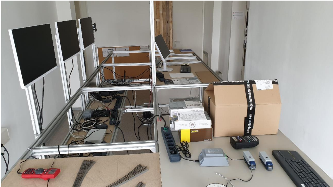
Abbildung 75 Implementierung der IT-Kommunikations- und Bildschirmtechnik, März 2019.
