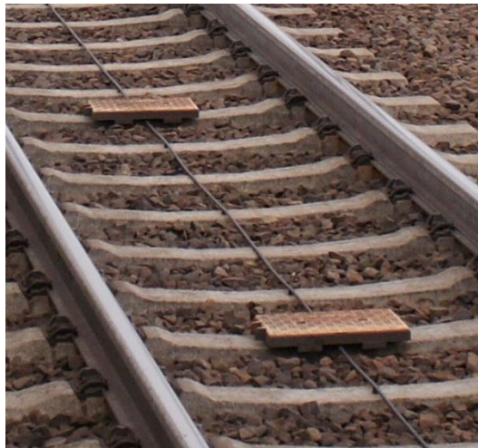
Abbildung 19 Eurobalisen zur Unterstützung der Positionserkennung auf der Strecke
