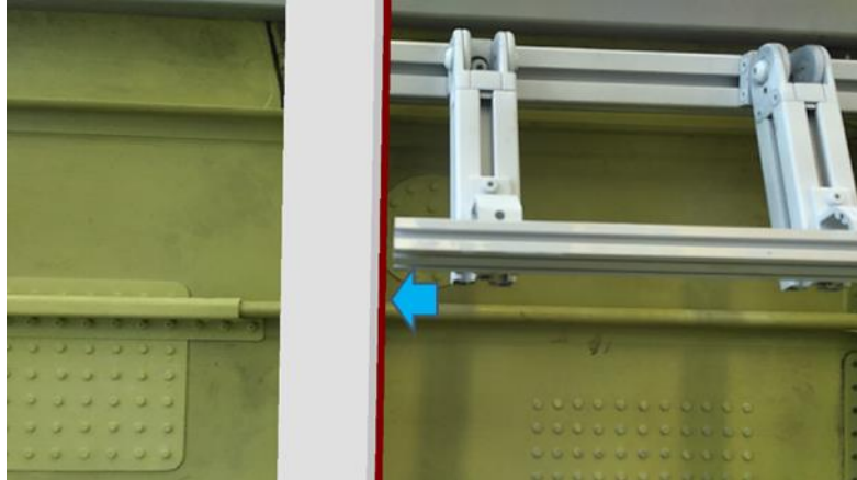
Bild 2-26: Manipulation des Kabinenelements zur Dokumentation der Eindringtiefe
