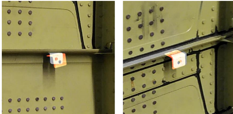
Bild 2-29: Fehlerhaft dokumentierter Halter vor und nach der Korrektur mittels des AR-Digitalisierungssystems [Den20]
