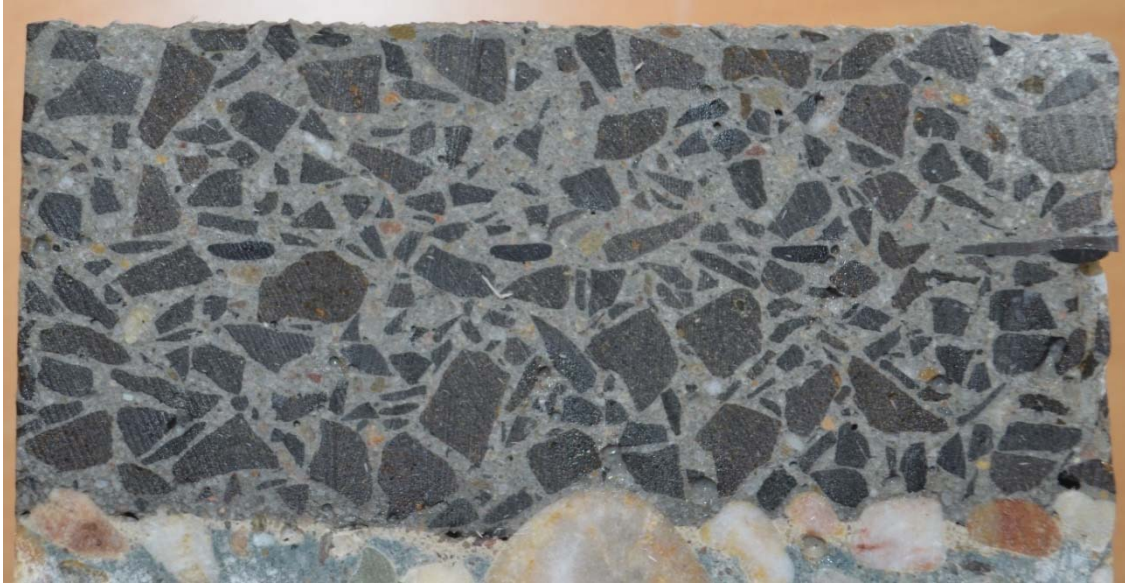
Abbildung 13: Durchdringung des Textil durch den Beton (Bohrkern aus einem Verbundbaken)
