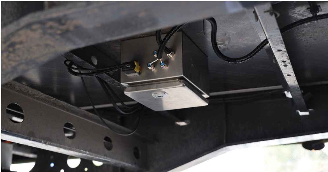
Bild 3: Anschaltbox für die Signale vom King-Pin
