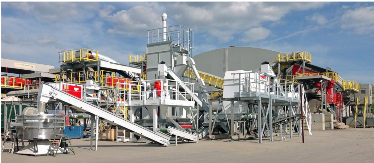
Abb. 2: Ansicht der Aufbereitungsanlage für Hausmüllverbrennungsrückstände (HMVA) in Wiesbaden: Alpha-Linie im Hintergrund, Beta-Linie (weiß) im Vordergrund.
