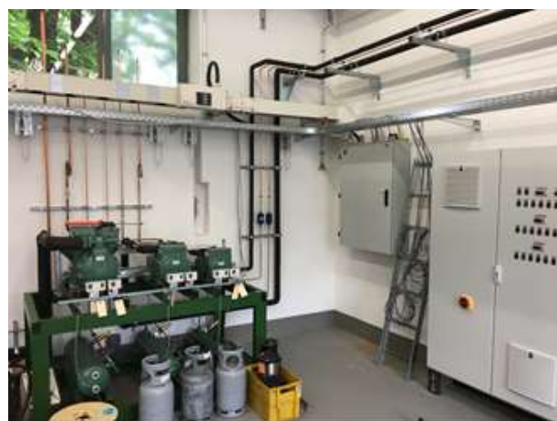
Abbildung 46: CAD Modell des Verdichtergestells (links); Verdichter und Schaltschrank für Kälteanlage (rechts).
