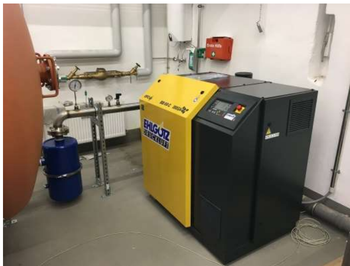
Abbildung 48: Kompressor und Filter des Höhensimulationsmoduls.
