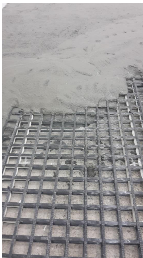
Bild 16: Einbindung des Carbonegewebes
