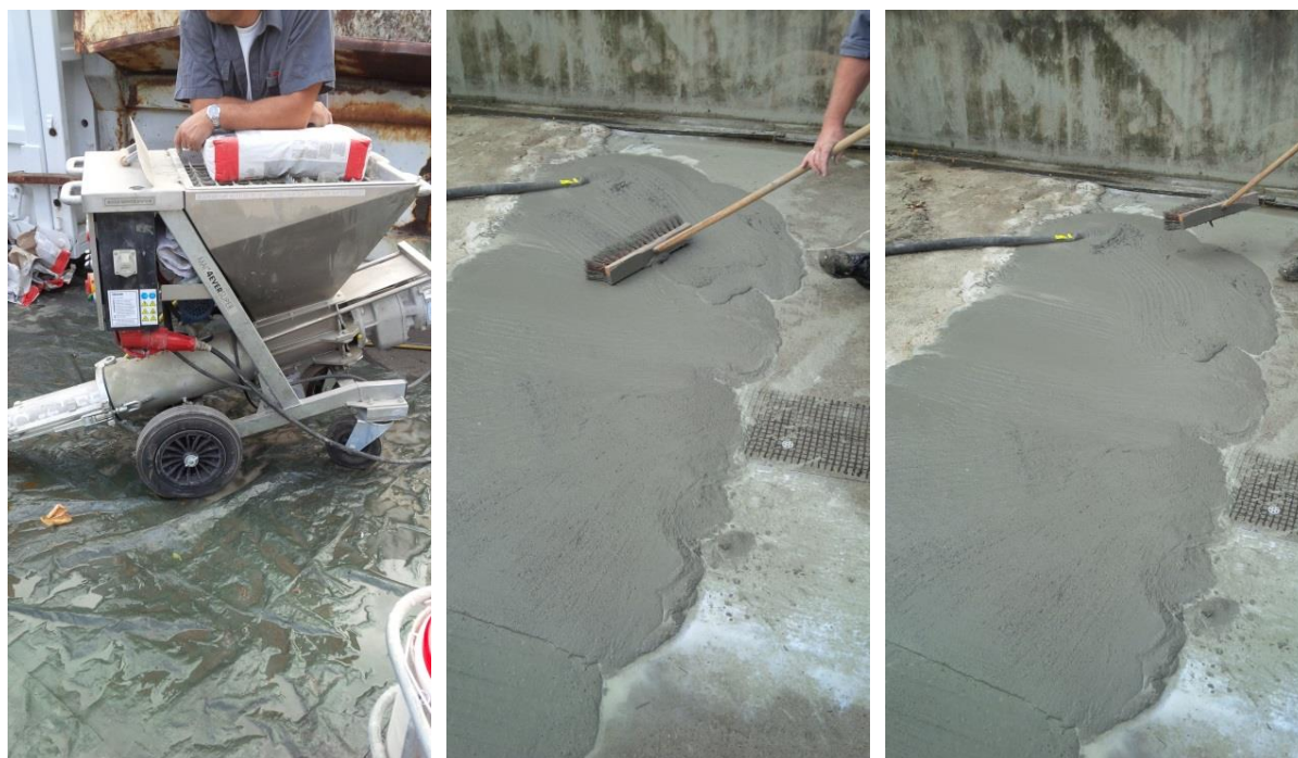
Bild 3-5: links: Mörtelmischmaschine; mitte: Einbau des Mörtels und Verteilen mittels Besens; rechts: Mörtel nach dem Einbau
