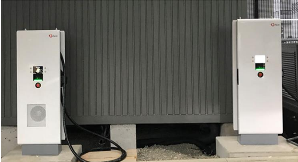
Abbildung 63 Bedieneinheiten 500 A (links) und 200 A (rechts) Porsche Weissach
