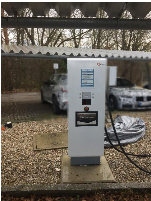
Abbildung 61 Bedieneinheit 200 A BMW Aschheim
