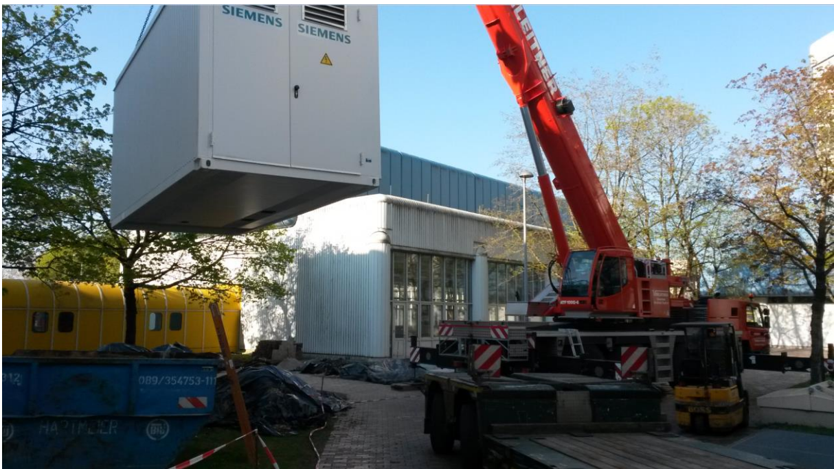
Abbildung 6 Containerplatzierung
