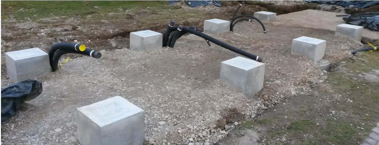
Abbildung 5 Einzelfundamentblöcke
