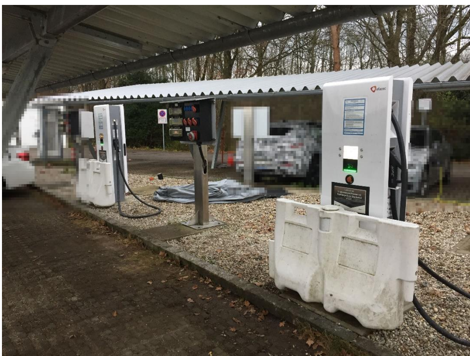
Abbildung 62 Bedieneinheiten 200A (links) und 500A (rechts) BMW Aschheim
