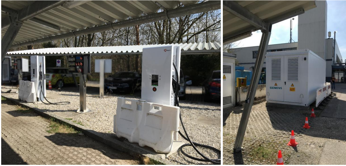
Abbildung 3 Container und Kioske nach Aufbau in Aschheim
