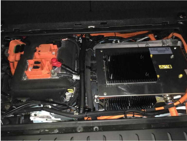
Abbildung 111 luftgekühlter Hochstromverteiler (rechts, Blick von oben)
