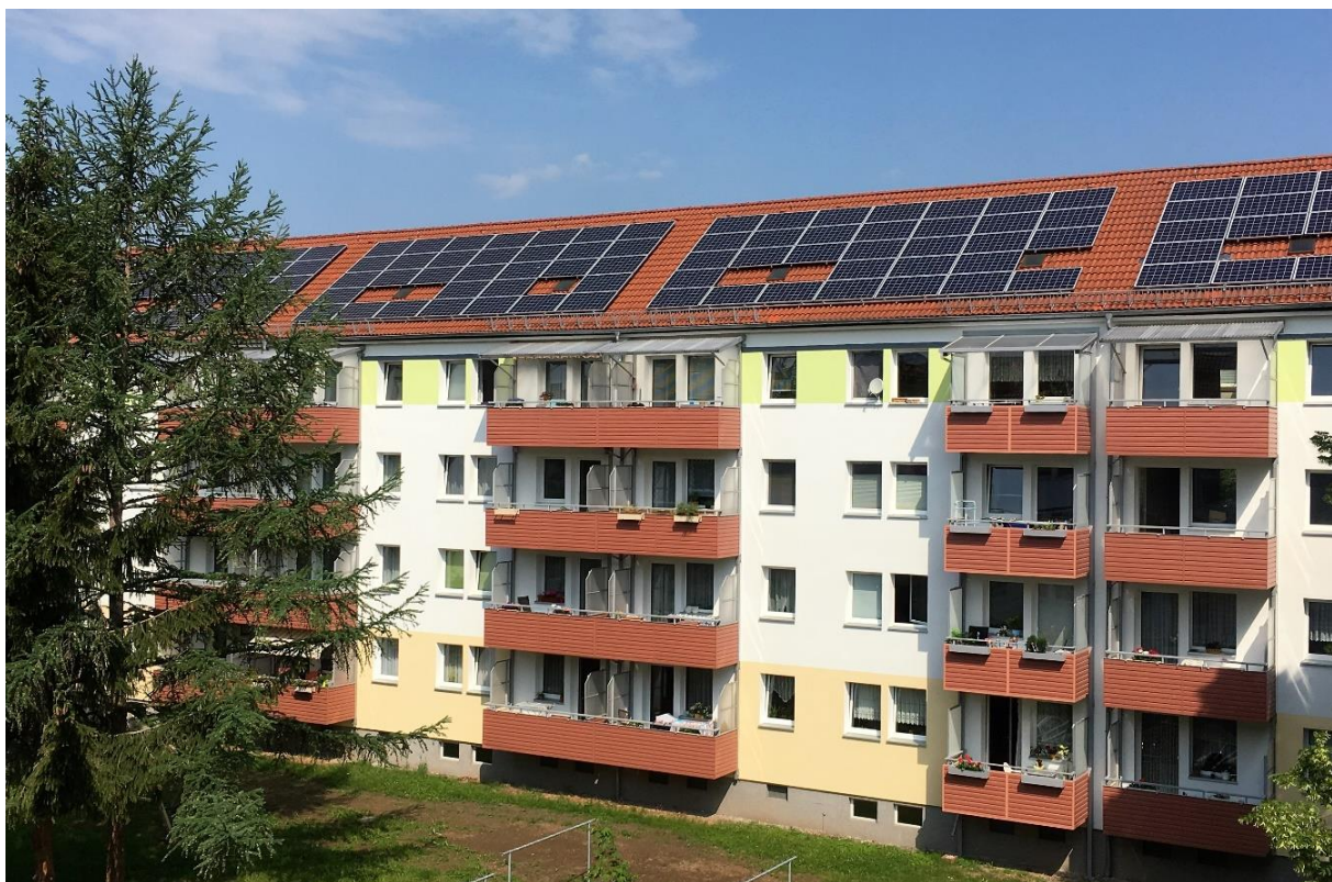
Abbildung 11: Photovoltaikanlage wohnungswirtschaftlicher Demonstrator, Alfons-Pech-Straße, Chemnitz.
