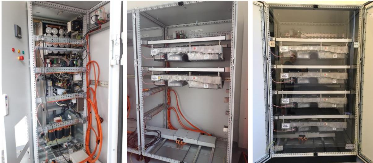
Abbildung 5: Einbau der Wechselrichter (links), der Traktionsbatterien (mitte) und Schutzwände aus Glas (rechts)
