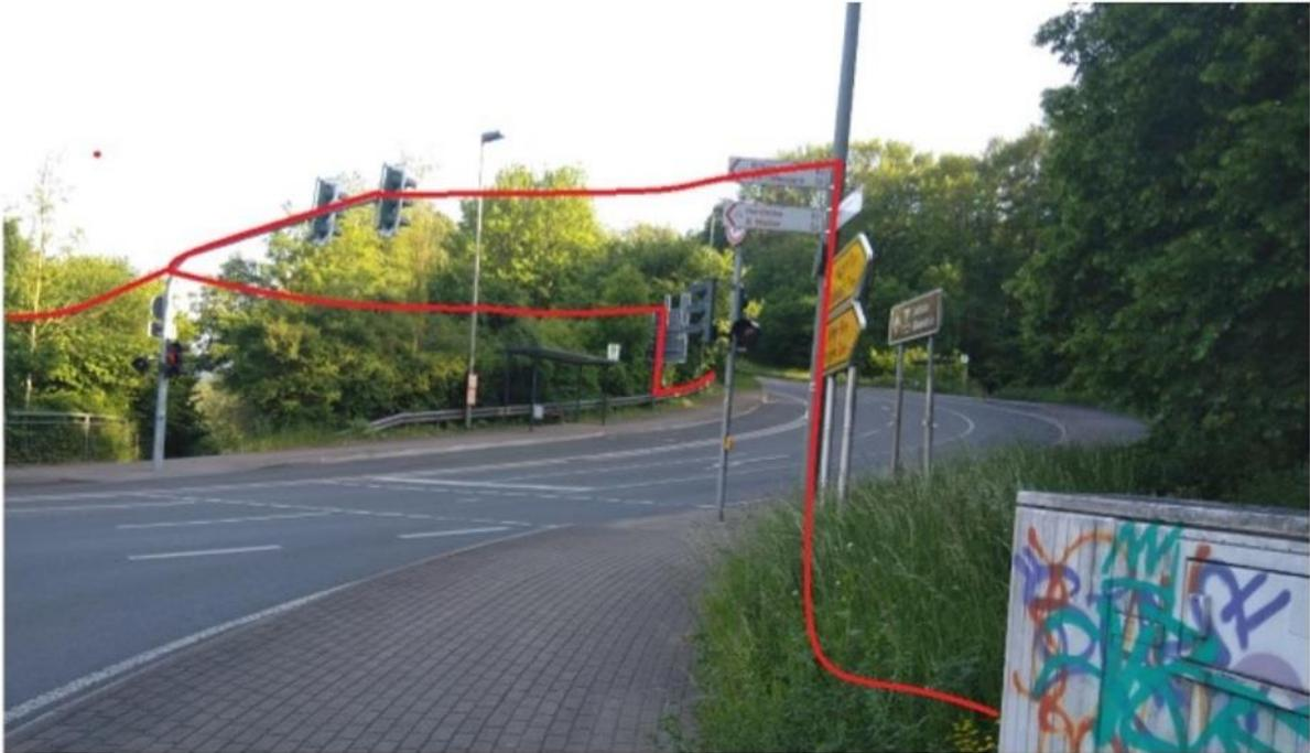
**Abbildung 35:** Prinzipbild zur fliegenden Energieverkabelung von LSA-SST zur Querung der B234
