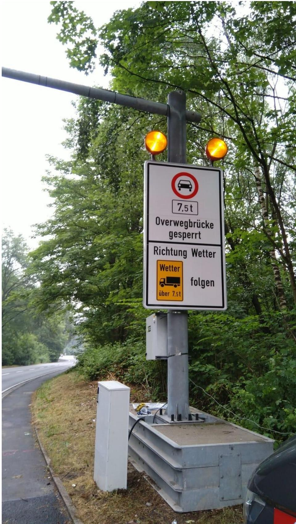
**Abbildung 18:** Mobile Aufstellvorrichtung mit Peitschenmastausleger
