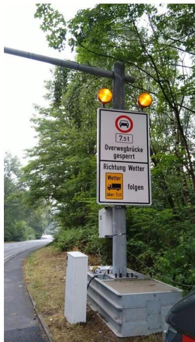
**Abbildung 38:** MQ 1 mit realisierter Energieversorgung über eine Hausanschlußsäule
