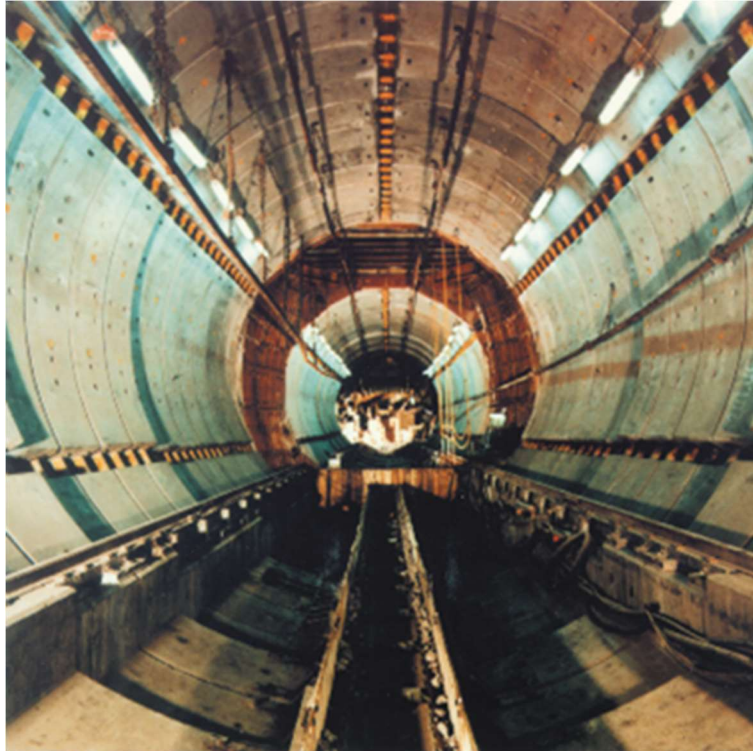
Abbildung 2-9: Füllort Ibbenbüren zweite Ausbauschaale (Haecker, 1987)
