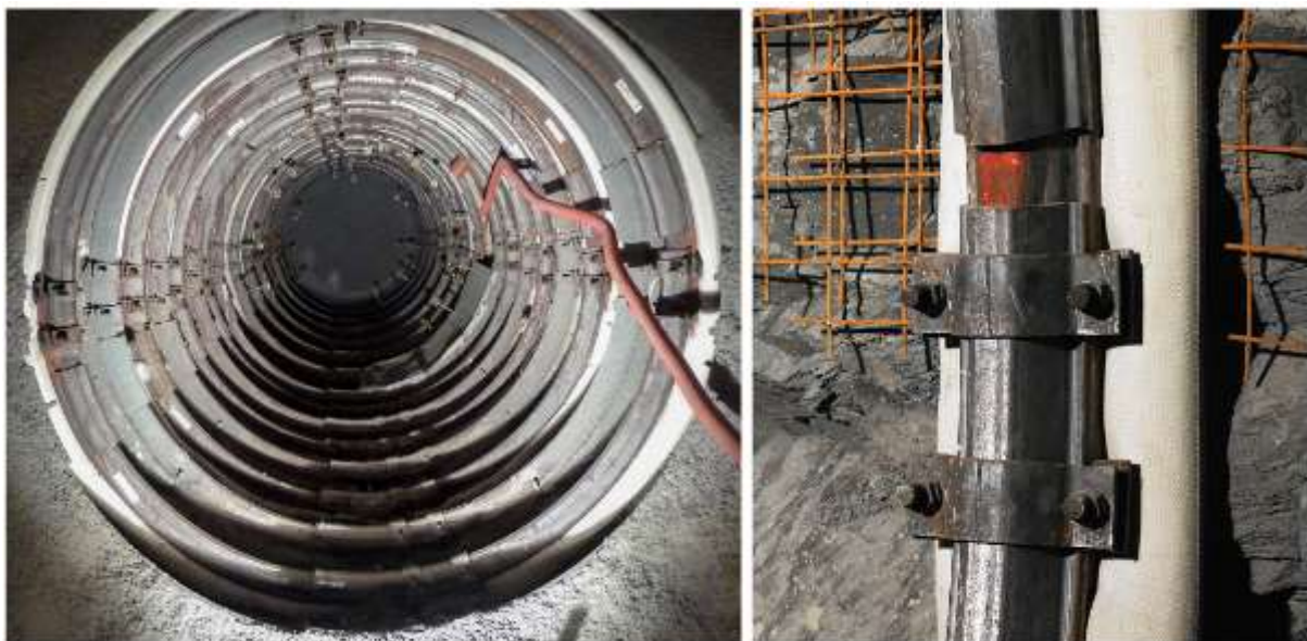
Abbildung 2-35: Links: Blick in den Abschnitt der späteren Zwischenversiegelung mit Gleichbogenausbau im FE-Experiment, rechts: Detailansicht eines Gleitbogens ergänzt durch Bullflexschlauch und Mattenverzug zur Kontursicherung (Nagra, 2015)
