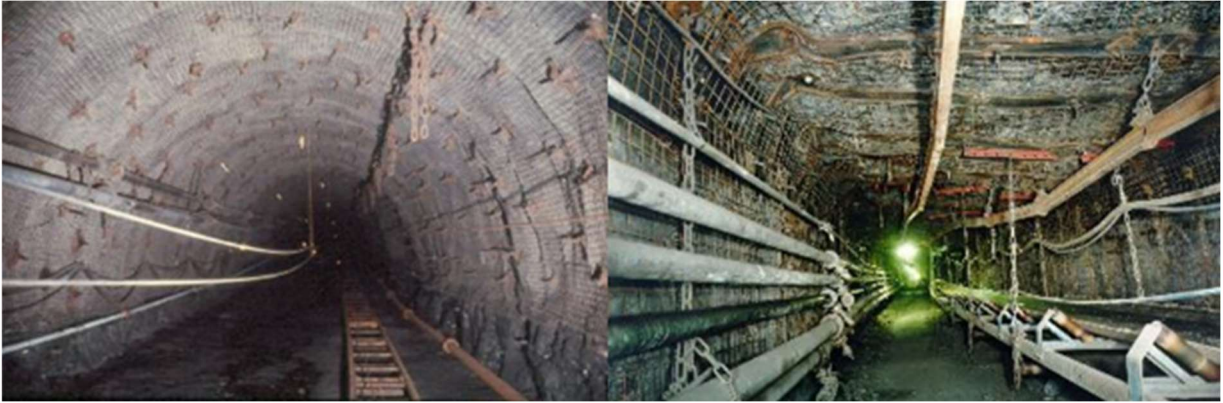
Abbildung 2-2: Ankerstrecken im deutschen Steinkohlentiefbau: links: Bogenstrecke in Ankerausbau mit Maschendrahtverzug (Archive DMT); rechts: Rechteckstrecke mit Ankern, W-Strips und Maschendraht (Junker et. al., 2006).
