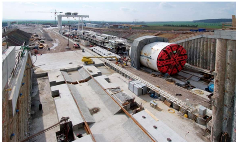
Abbildung 2-17: Tunnelvortriebsmaschine Boßlertunnel (Breidenstein, 2012)
