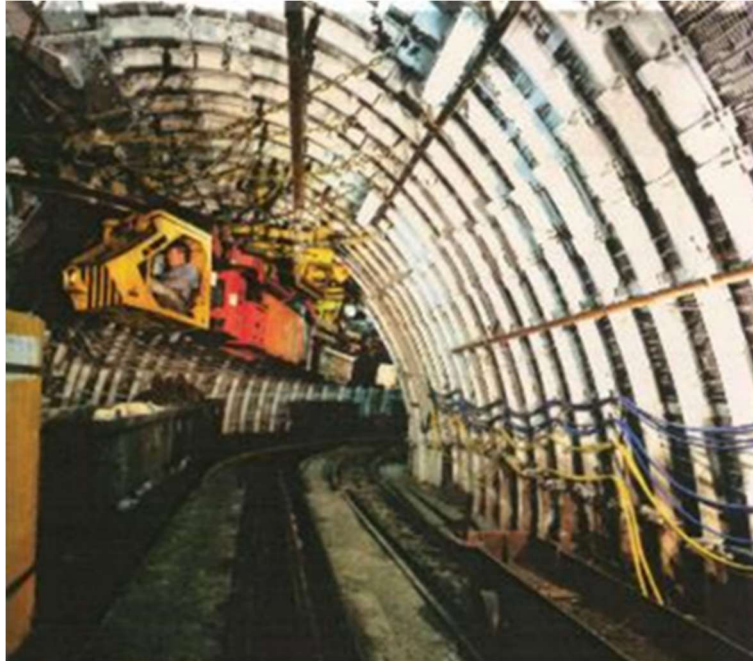
Abbildung 2-4: Nachgiebiger Bogenausbau (Bildarchiv DMT)
