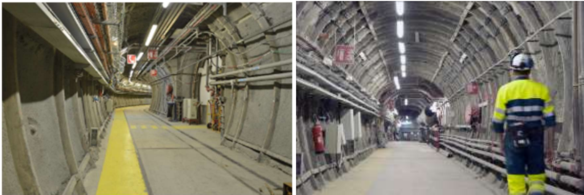
Abbildung 2-40: Gleitbogenausbau, beides nach (ENYGF, 2019)
