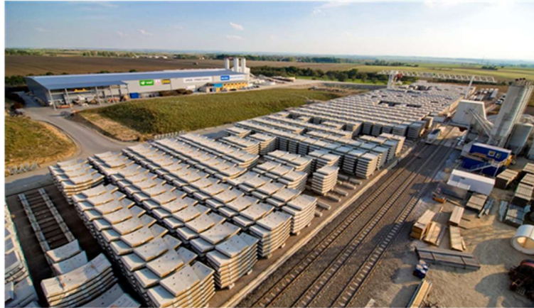
Abbildung 2-20: Boßlertunnel Tübbingfabrik und -lager (Breidenstein, 2012)
