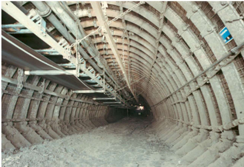
Abbildung 2-11: Richtstrecke SO 48 nach Fertigstellung der Innenschale (Bildarchiv DMT)
