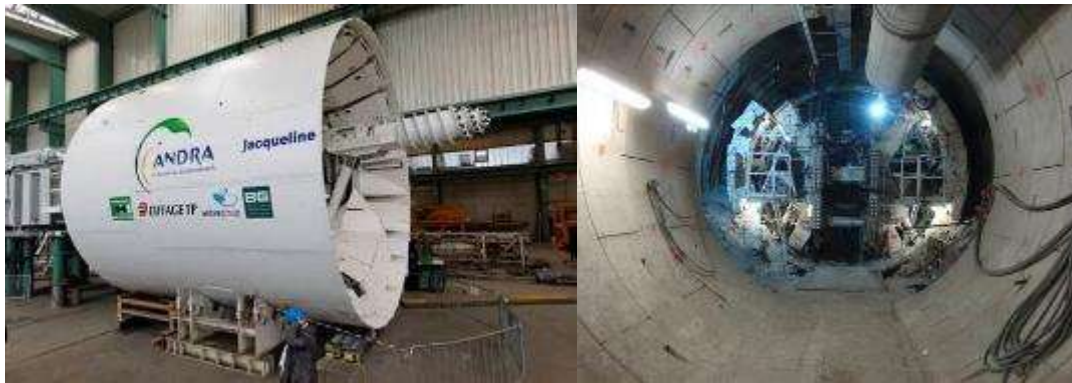
Abbildung 2-44: Links: Die zum Vortrieb eingesetzte Schildmaschine mit Fräskopf. Rechts: Die mit Tübbing ausgebaute Strecke GRD4 (Delay et al., 2019)
