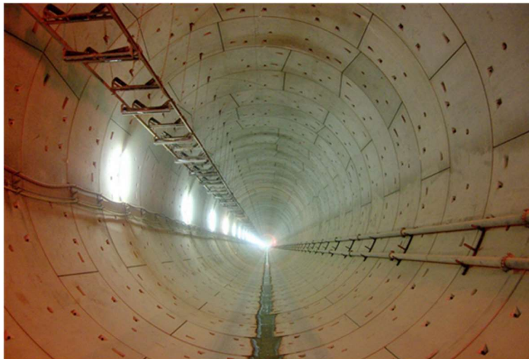
Abbildung 2-19: Boßlertunnel Tübbingausbau (Breidenstein, 2012)
