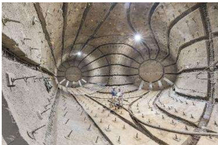
Abbildung 2-50: Geschlitzter Anker-Spritzbeton-Ausbau Schacht Konrad (BGE, 2020)
