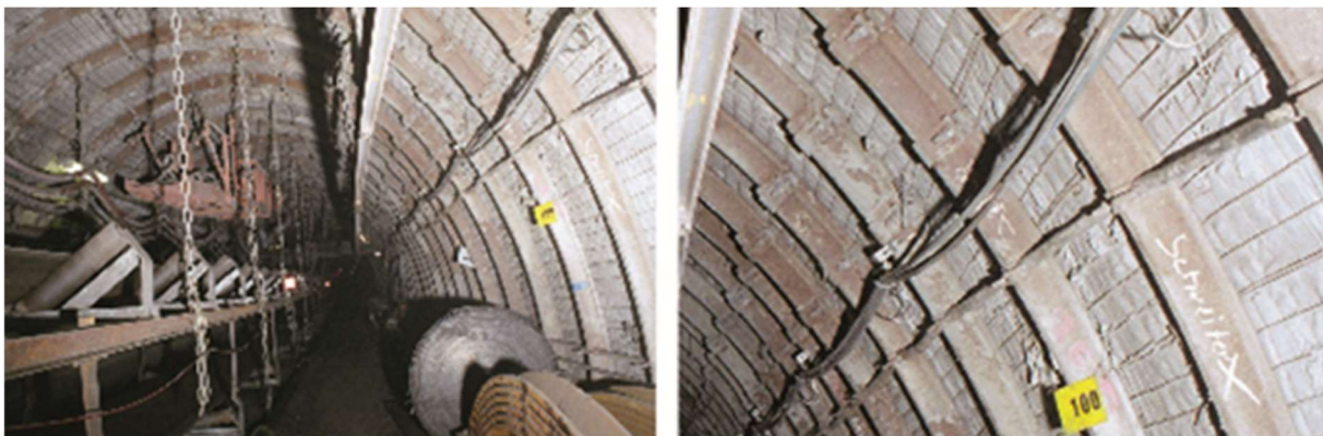
Abbildung 2-5: Baustoffhinterfüllte Gleitbogenstrecke (Junker et. al., 2006)
