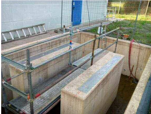
Abbildung 4-20: Links: Schablone für die Ankerbolzen auf das Speicherfundament in Wellesweiler. Rechts: montierte Ankerbolzen.
