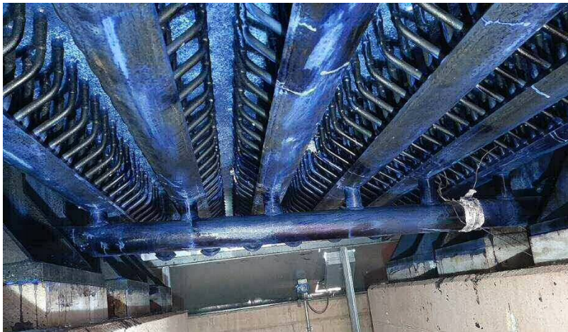
Abbildung 5-8: Speicher nach der Besprühung mit Rostumwandler.
