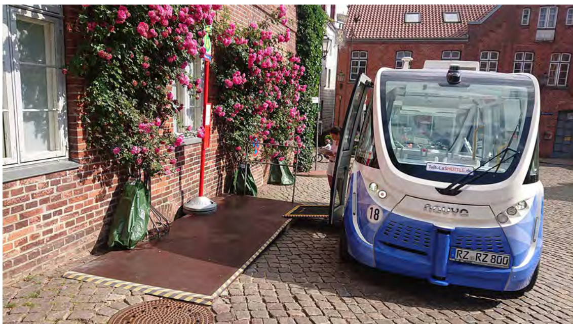
Abbildung 37: Temporär aus Holz unter Berücksichtigung des Denkmalschutzes umgebaute TaBuLa-Haltestelle am Kirchplatz
