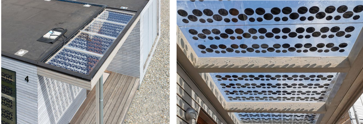
Abbildung 42: Montage der Überkopfverglasung mittels Pressleisten. Links Aufsicht mit Pyranometer, rechts Durchsicht mit unsichtbarer Befestigung
