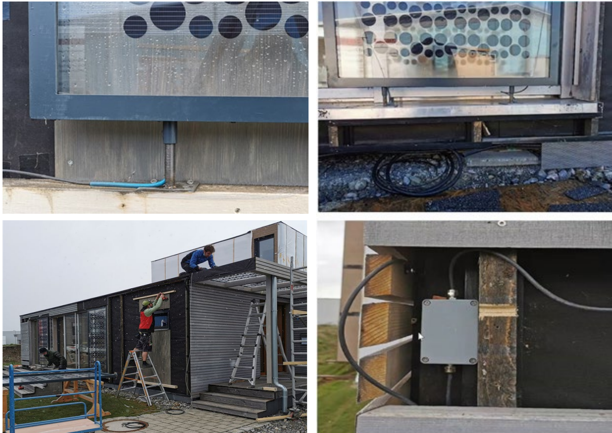
Abbildung 46: Ausschnitte von der Baustelle: Fußteil der Fassadenmodule vor der Installation; Aufständerung der Fassadenmodule vor der Prallscheibe; Kabelführung im Fußpunkt der Fassadenmodule; Montagbox für Temperatur und Strahlungssensor in der Fassade
