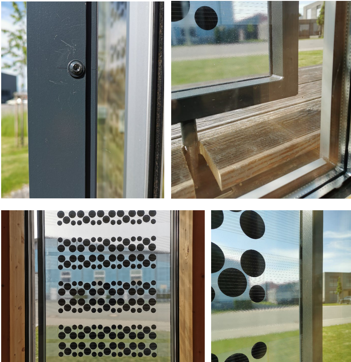
Abbildung 41: Ausblicke: Durchsicht und Details der Rahmenkonstruktion von Innen
