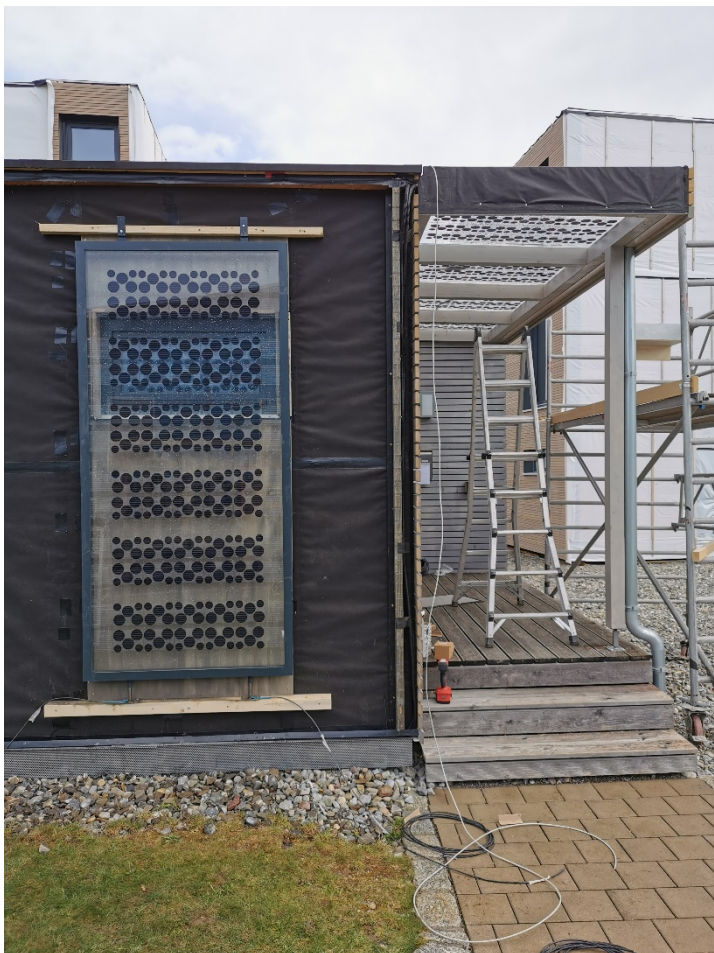
Abbildung 47: Montage der Überkopfverglasung, der Prallscheiben und installierter Schaltschrank mit Messtechnik
