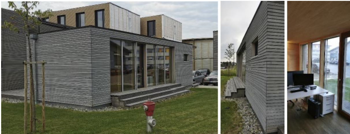
Abbildung 31: Musterhaus der Firma VariaHome am Firmenstandort in Wangen im Allgäu (Bürogebäude)
