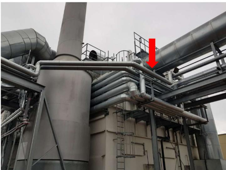
Abbildung 7: Einspeisung des  $\mu$ GT-Abgases kurz vor der RTO-Anlage
