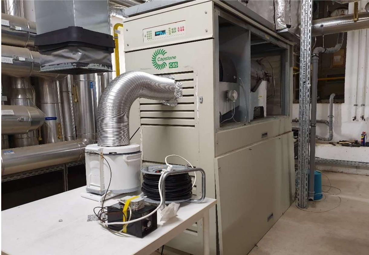
Abbildung 12: Verbrennungsluftansaugung über Verdampferbad und Ansaugrohr
