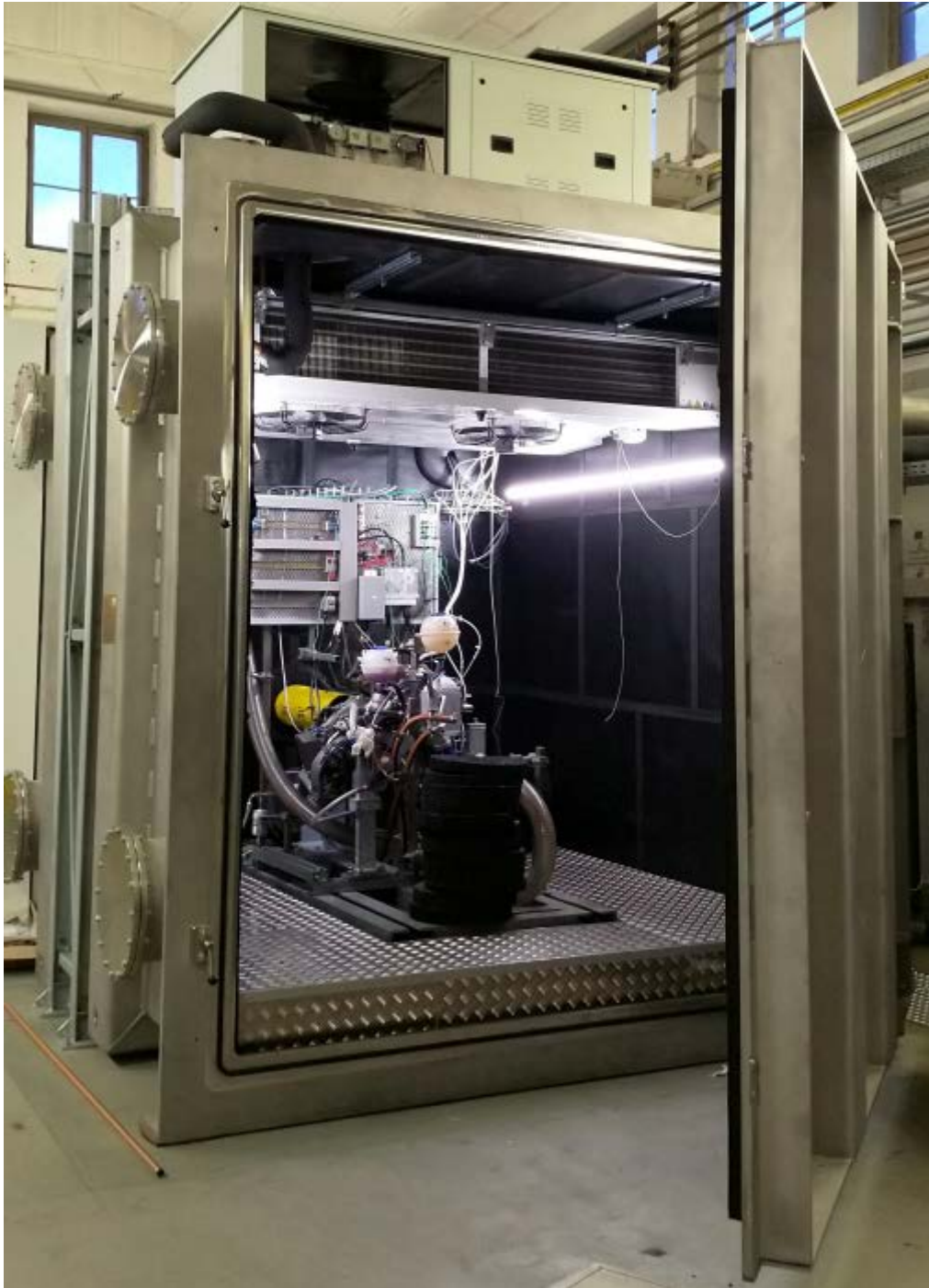
Abbildung 6.50: Installation der Standklimatisierung in der Höhenkammer
