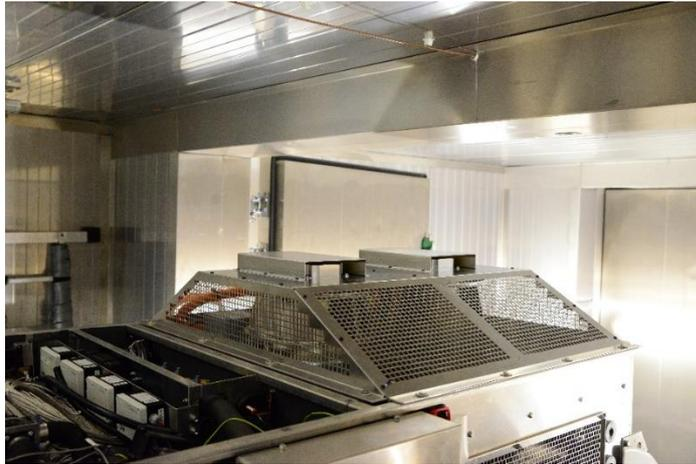
*Abbildung 28: Wärmepumpe mit neuen Gebläsen*
