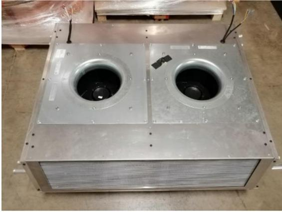
Abbildung 3: Versuchsträger (A-Muster) mit Gebläsemotoren inkl. integrierter Leistungselektronik
