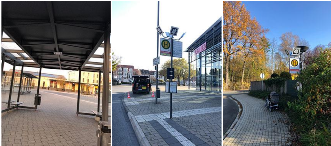
Abbildung 30: Bsp. für die Montage der Marker im Haltestellenunterstand (Links) und Haltestellenmast (Mitte) am Bahnhof Soest sowie am Haltestellenmast der Haltestelle LWL (Rechts)
