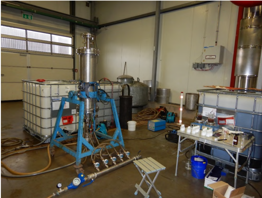
Abbildung 7: Testeinsatz des HydroGeoFilt Filtersystems unter geothermischen Bedingungen an der Geothermieanlage Insheim.
