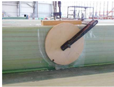
Abbildung 68: Fixierung der Verbindungsstelle der Stegsegmente
