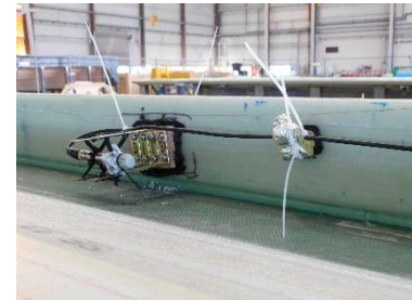
Abbildung 77: Einbau von Sensorik vor dem Verkleben der Rotorblattschalen
