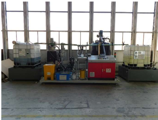
Abbildung 28: Harzinfusionsanlage "2KM ResinMix 2c" mit Harz- und Härter-Vorratsbehälter
