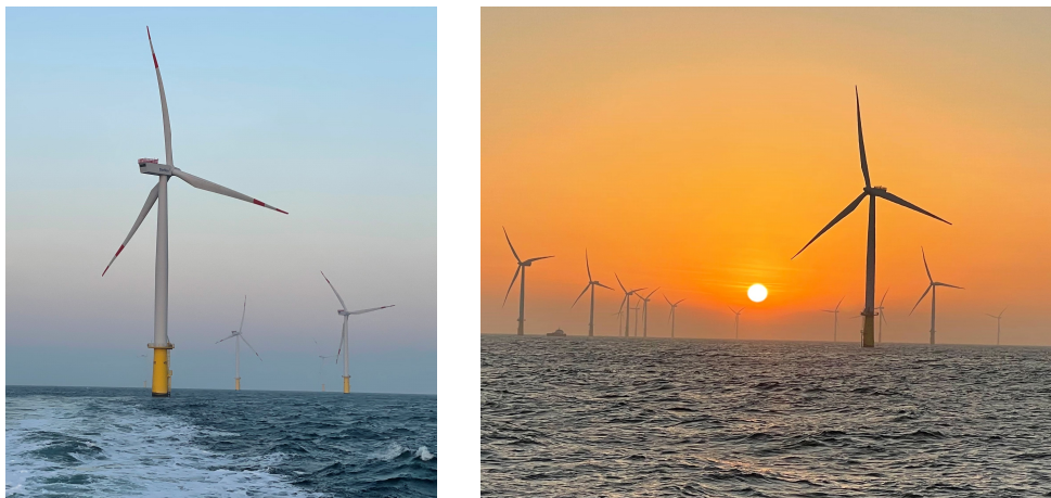
Abbildung 93: Fotografien der WEA im Offshore-Windpark Meerwind Süd | Ost
