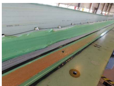
Abbildung 70: Auftrag des Klebstoffs auf der Klebelippe an der Vorderkante
