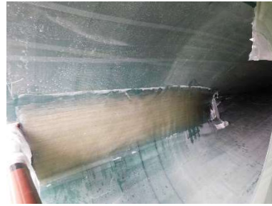
Abbildung 74: Innenlaminat nach Klebstoffauftrag (Hinterkante links, Vorderkante rechts)
