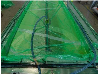
Abbildung 56: Vakuuminfusion des Stegs
