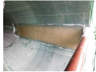
Abbildung 74: Innenlaminat nach Klebstoffauftrag (Hinterkante links, Vorderkante rechts)
