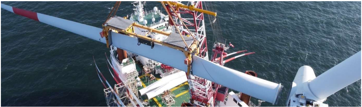
Abbildung 166: Rotorblatthebegestell
