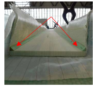
Abbildung 55: Schaumkeile für den besseren Kraftfluss
