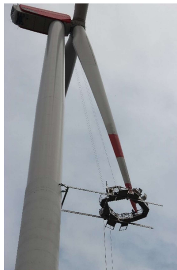
Abbildung 3: Blattreparatur an einer N117
