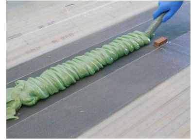
Abbildung 64: Kleberauftrag auf der Saugseitenschale mit Schubsteg-Anschlag
