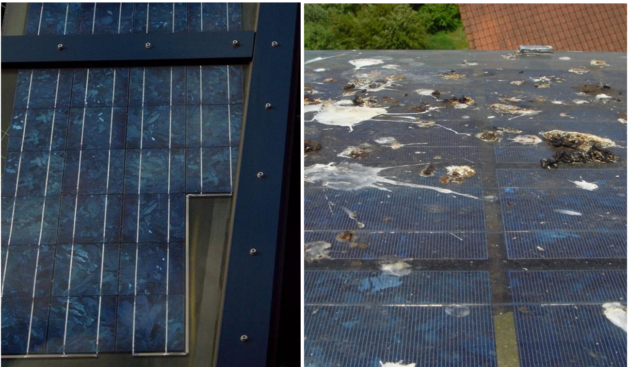
Abbildung 4-11: Beispiele für eine Mesoverschattung; links: permanente Verschattung durch Halterung, rechts: temporäre Verschattung durch Vogelkot.
