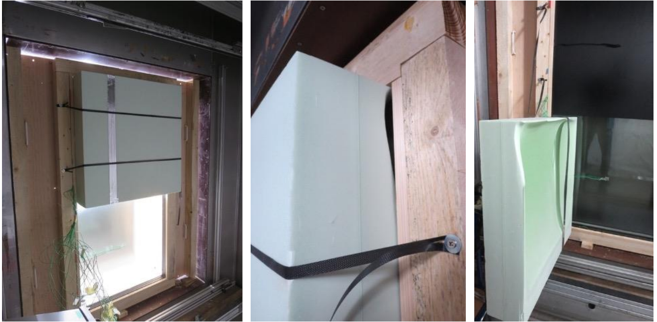
Abbildung 8-13: Wärmedämmglas - Teilverschattung unten, Wärmedämmung oben, mit schwarzer Folie - geschmolzene Wärmedämmung.
