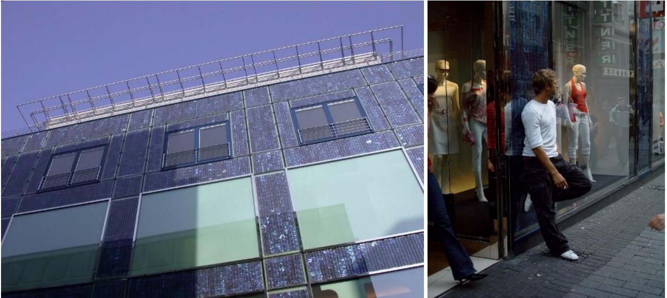
Abbildung 4-12: Beispiele für Makroverschattung; links: permanente Verschattung durch Nachbargebäude, rechts: temporäre Verschattung durch Person.
