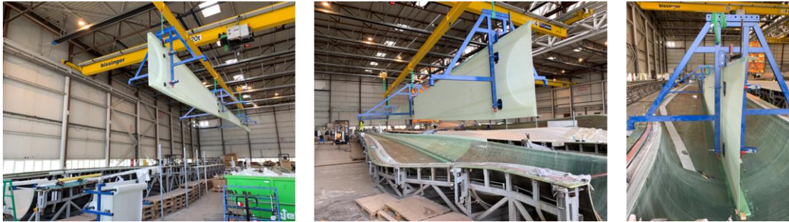
Abbildung 27: Einsetzen des Schubsteges
