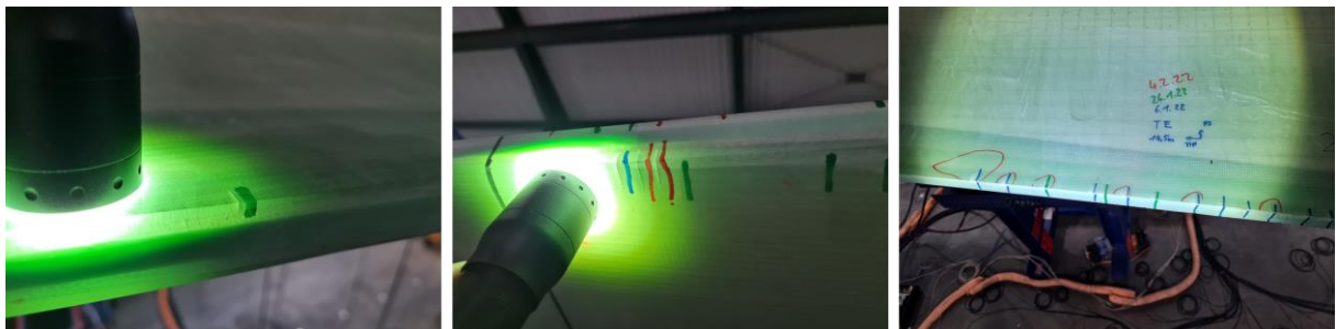
Abbildung 35: Schadensbild Klebverbindung Endkante
