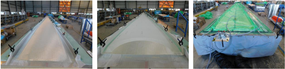
Abbildung 17: Fertigung des Schubsteges
