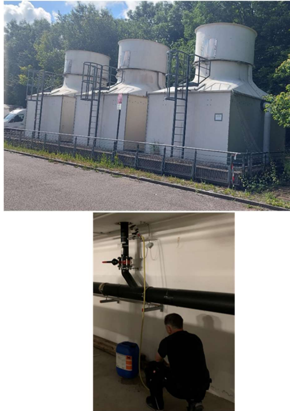
Abbildung 3: Lageplan der Verdunstungskühlanlagen an der TUM (a). Fotos des Verdunstungskühlturms und Probenahmestelle für die Untersuchung des Kühlwassers (b).
