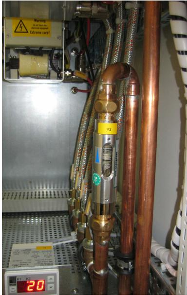
Abbildung 4: Wasserdurchlaufsmesser
