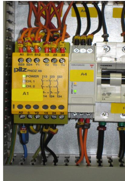
**Abbildung 3:** Interlockkreis + Stromrichtung
