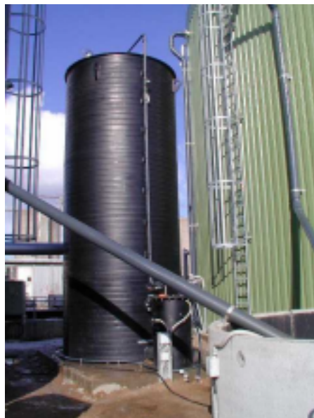
Abbildung 5: BioSulfex ® -Verfahren; Beispiel landwirtschaftliche Biogasanlage (Rohgasmenge 260 m 3 /h, Rohgas 2.500 ppm H 2 S, Reingas mind. < 300 ppm H 2 S, Leistungsbedarf im Dauerbetrieb < 1kW e,l )
