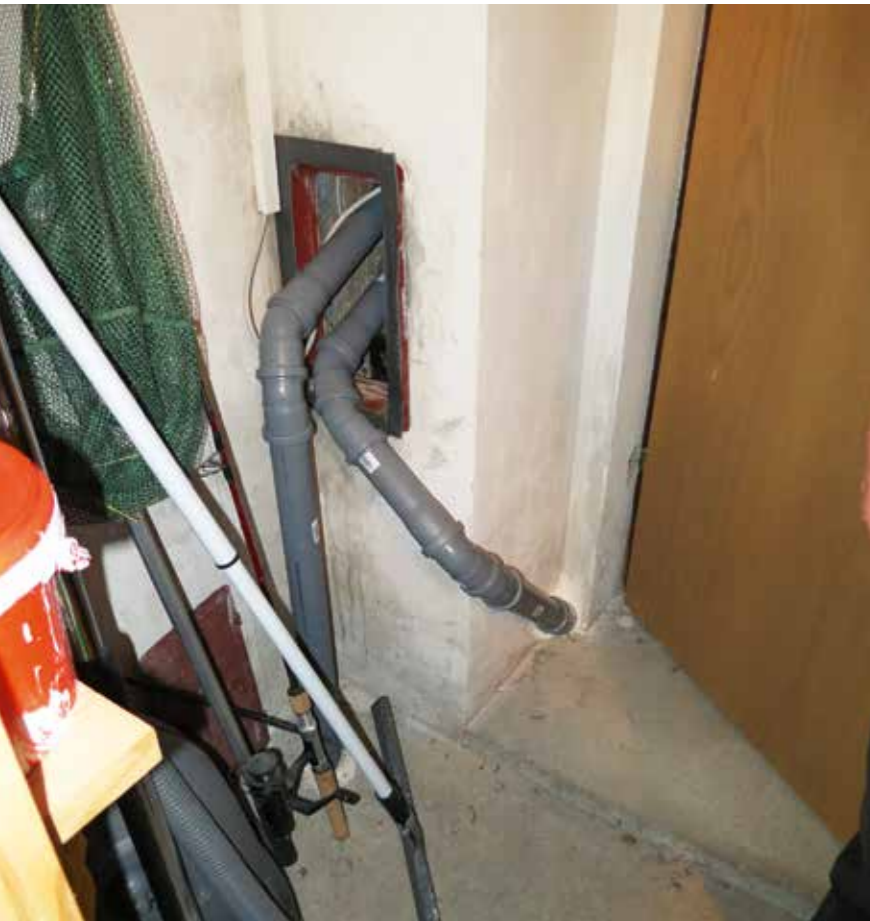
Rohrführung im Rahmen einer Unterbodenabsaugung über einen stillgelegten Abgasfang (Radonsanierung in einem Privathaus)
