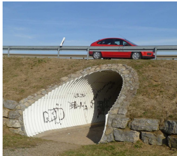
Bild 1. Typisches Wellstahlbauwerk als Verkehrswegunterführung
