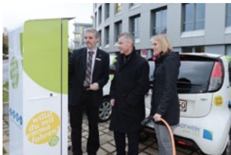
Ladeinfrastruktur im öffentlichen Raum (s. Kap. 5.1.4)
