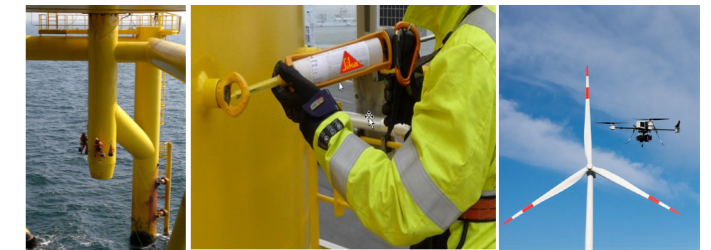
Inspektion/Reparatur einer OWEA-Anlage und Drohrentechnik (Quellen: Muehlhan AG, Sika GmbH, IFAM)
