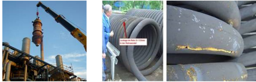
Abbildung: Demontage 40t Wärmetauscher; Leckage in unbeschichteten Anlagen
