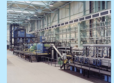
Kontinuierliche Bandversuchsanlage für neue Technologien BPA 300 (Quelle: eigenes Foto)
