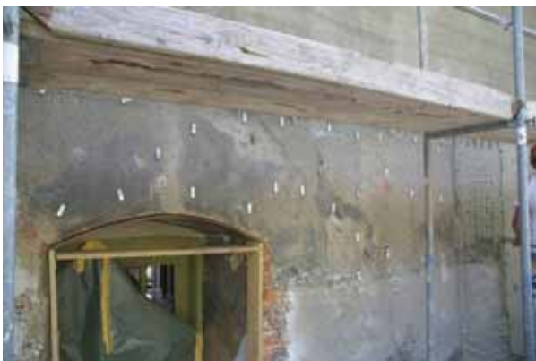
Abb. 63 Beamtenhaus, Nordwestfassade, Sicherung barocker Putzoberflächen, Aufnahme am 25.08.2010
