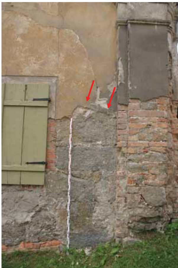
Abb. 11 Beamtenhaus, Probenahmepunkte M_KG_M2 (links) und M_KG_M4 (rechts)
