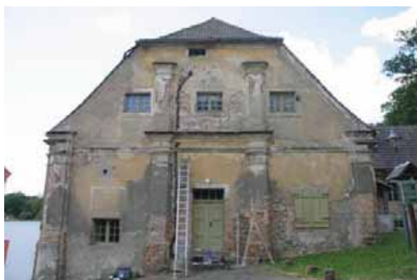
Abb. 70 Beamtenhaus, Schmuckgiebel vor der Restaurierung (07.07.2010)
