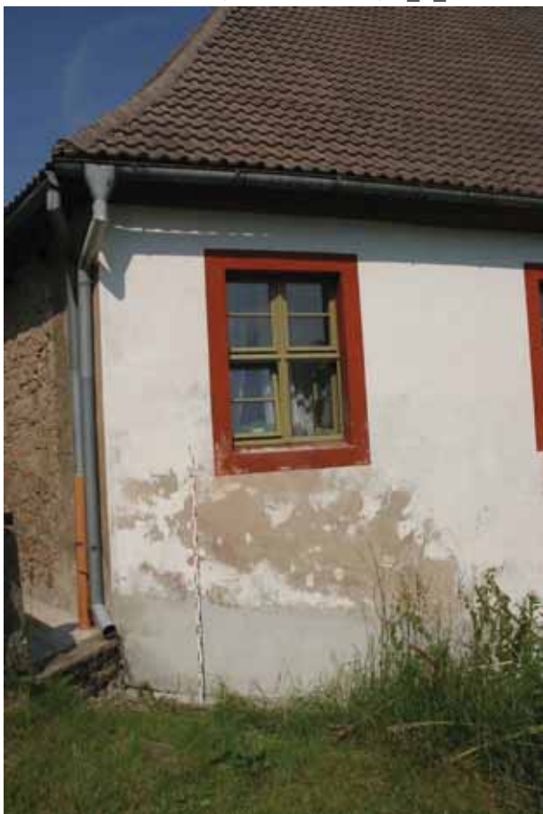
Abb. 16 Beamtenhaus, Südwestfassade, M_K_TP2
