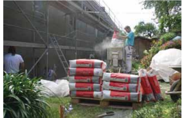
Abb. 62 Beamtenhaus, Nordwestfassade, Putzarbeiten, Aufnahme am 25.08.2010
