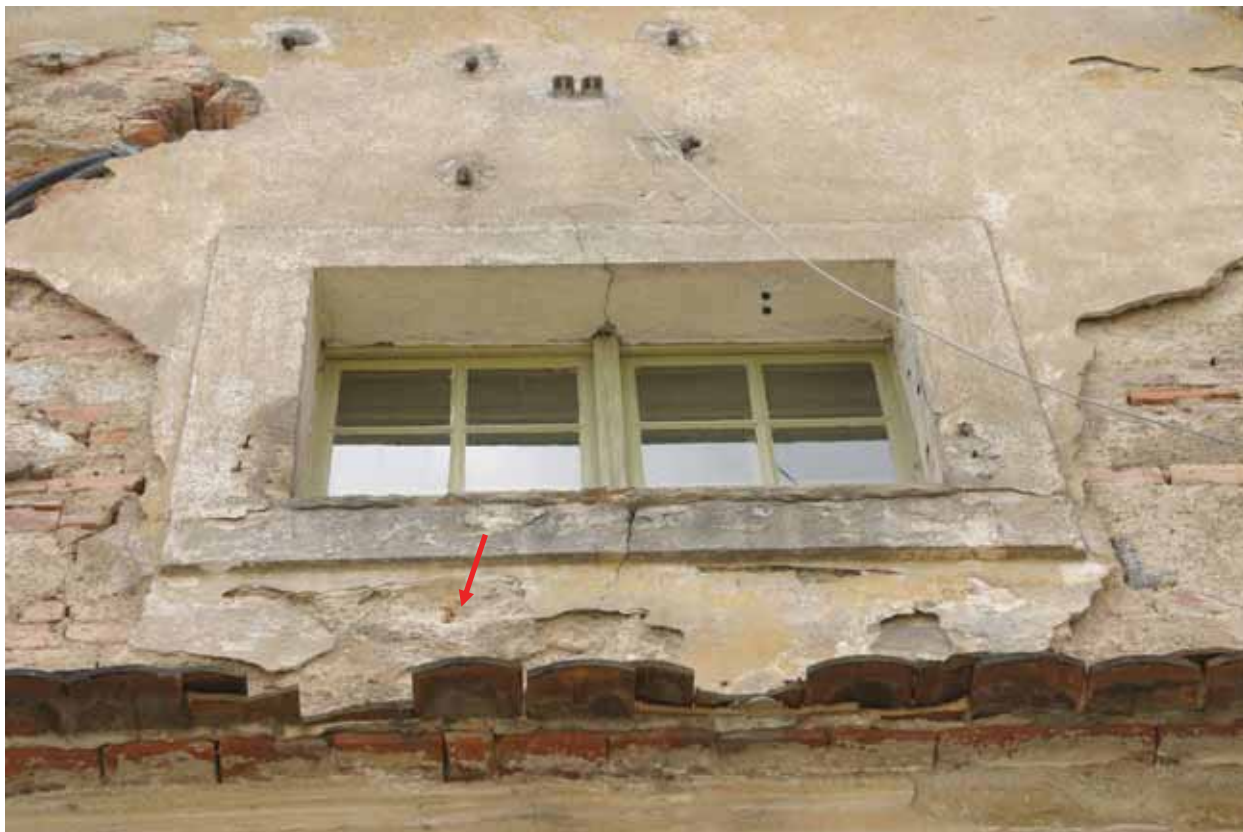
Abb. 8 Beamtenhaus, Giebel, Probenahmepunkt MKG_TP3_F (Fuge)
