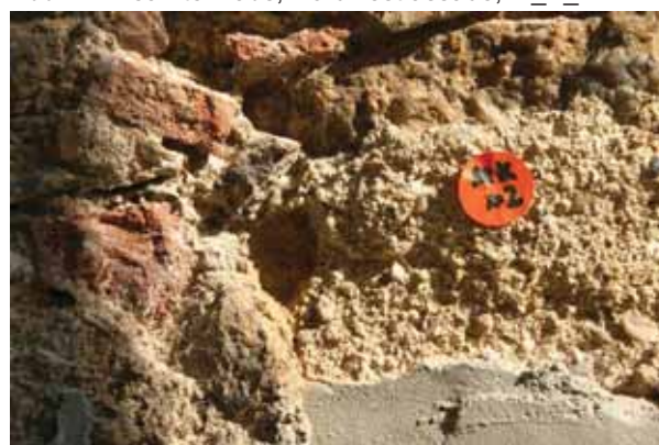
Abb. 24 Beamtenhaus, Nordwestfassade, M_K_M2
