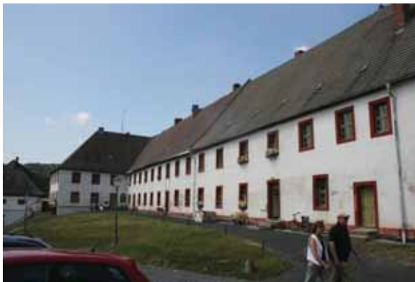
Abb. 67 Beamtenhaus, Hoffassade vor der Restaurierung
