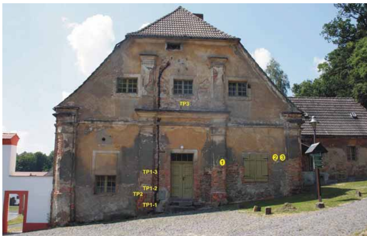
Abb. 25 Beamtenhaus, Giebel, Übersicht der Probenahmepunkte
