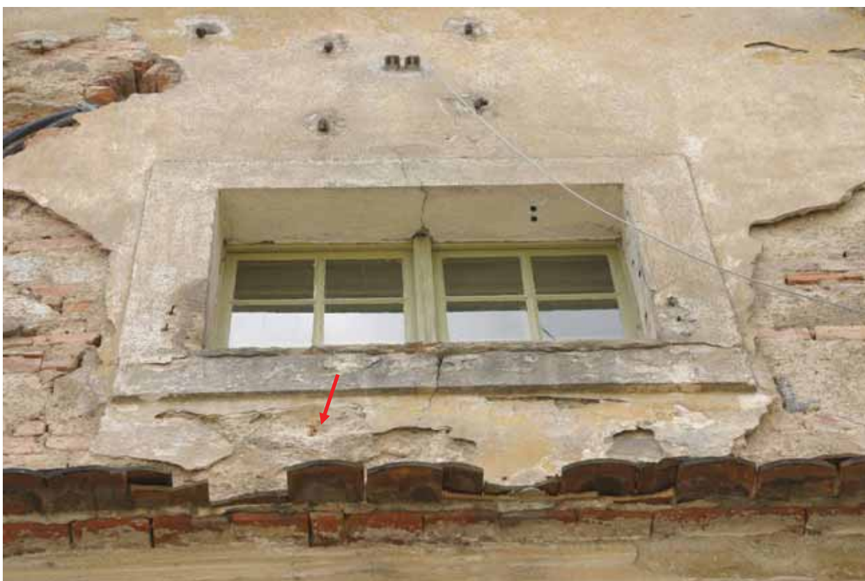
Abb. 31 Beamtenhaus, Giebel, Probenahmepunkt MKG_TP3_F (Fuge)
