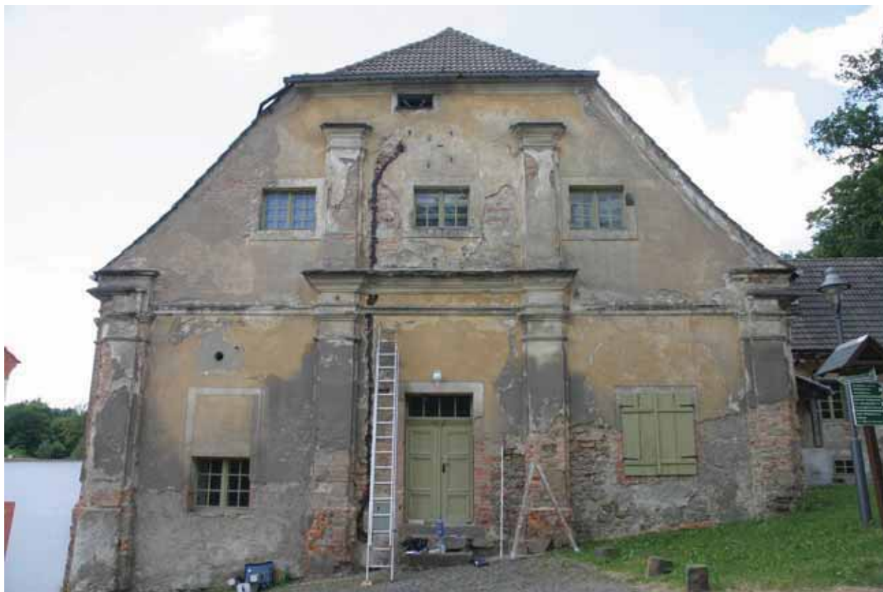
Abb. 1 Kloster Marienthal, Beamtenhaus, Giebel, Aufnahme am Tag der Probenahme
