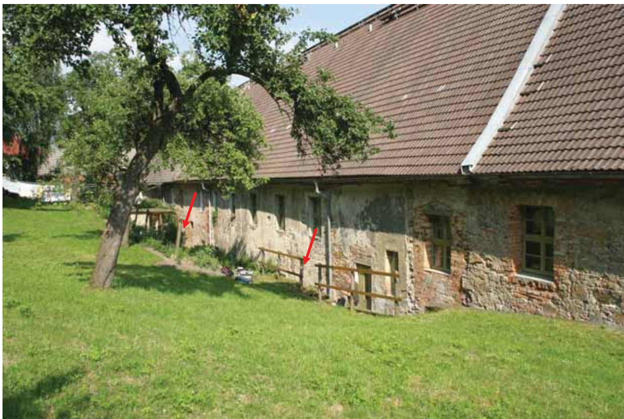
Abb. 18 Beamtenhaus, Nordwestfassade, Probenahmepunkte M_K_TP3 und M_K_TP4
