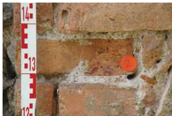
Abb. 5 Beamtenhaus, Giebel, Pilaster, Tiefenprofil MKG_TP1_2/
