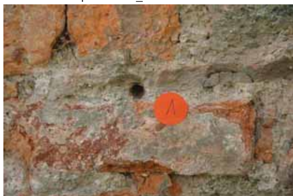
Abb. 4 Beamtenhaus, Giebel, Pilaster, Tiefenprofil MKG_TP1_1/
