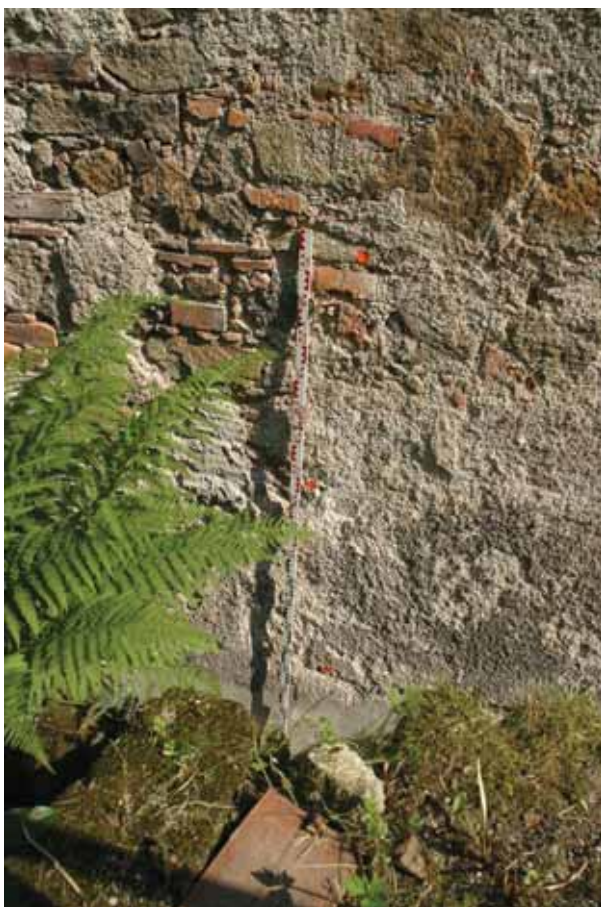
Abb. 19 Beamtenhaus, Nordwestfassade, M_K_TP3
