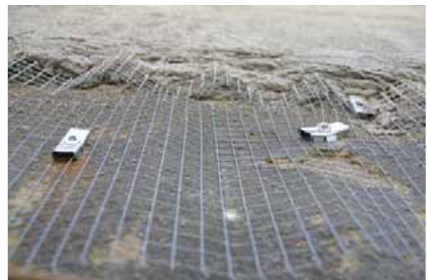
Abb. 64 Beamtenhaus, Nordwestfassade, Sicherung barocker Putzoberflächen, Aufnahme am 25.08.2010
