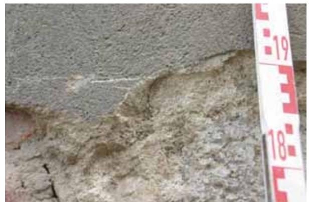
Abb. 60 Beamtenhaus, Giebel, Materialwechsel Zementmörtel (links) / Kalkmörtel (rechts)
