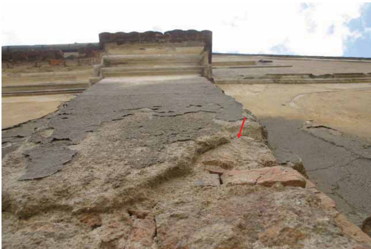
Abb. 9 Beamtenhaus, Giebel, Pilaster, Probenahmepunkt M_KG_M1
