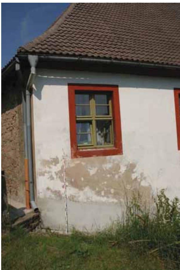
Abb. 5 Beamtenhaus, Südwestfassade, M_K_TP2
