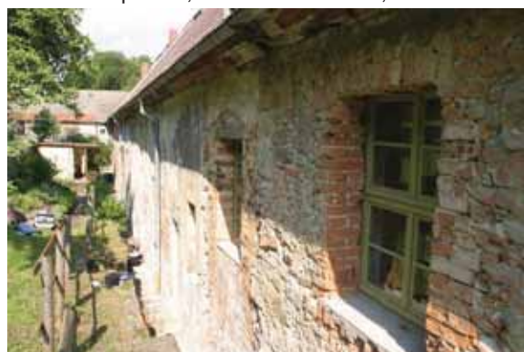
Abb. 7 Haupthaus, Nordwestfassade mittlerer Bereich, 25.06.2010
