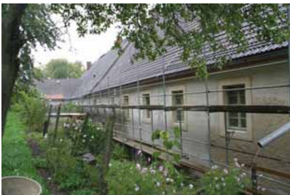
Abb. 65 Beamtenhaus, Nordwestfassade, nach Applikation des Wärmedämmputzes, Aufnahme am 15.09.2010
