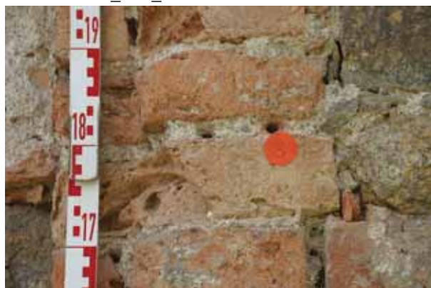
Abb. 6 Beamtenhaus, Giebel, Pilaster, Tiefenprofil MKG_TP1_3/
