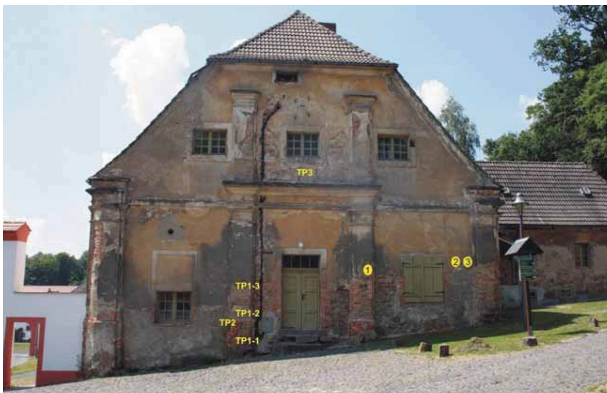
Abb. 2 Beamtenhaus, Giebel, Übersicht der Probenahmepunkte
