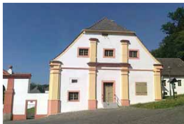
Abb. 71 Beamtenhaus, Schmuckgiebel nach der Restaurierung (18.05.2011)
