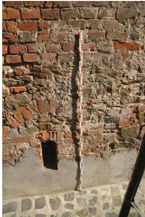
Abb. 9 Beamtenhaus, Nordwestfassade, M_K_TP4
