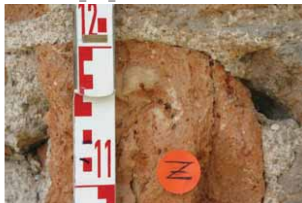
Abb. 7 Beamtenhaus, Giebel, Pilaster, Tiefenprofil MKG_TP2_Z (Ziegel)
