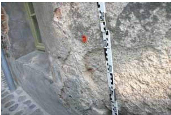
Abb. 10 Beamtenhaus, Nordwestfassade, M_K_M1
