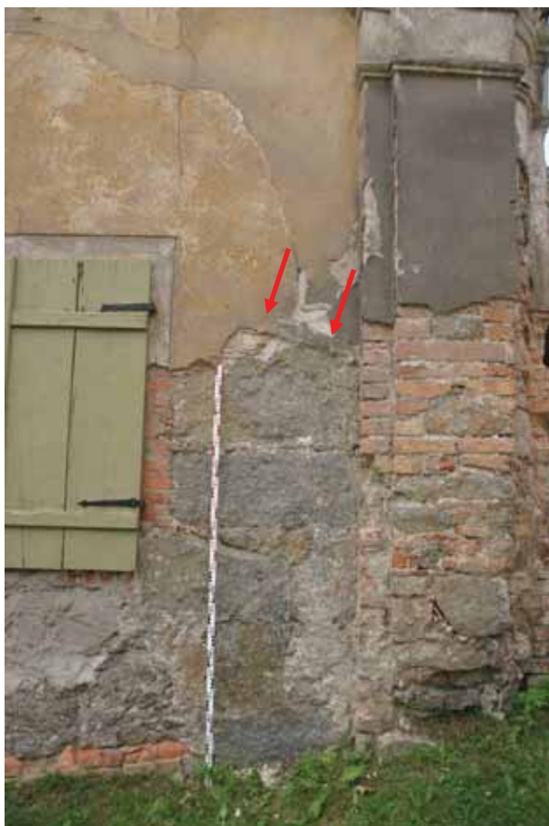
Abb. 34 Beamtenhaus, Probenahmepunkte M_KG_M2 (links) und M_KG_M4 (rechts)
