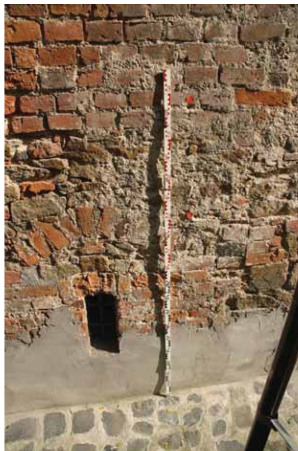
Abb. 20 Beamtenhaus, Nordwestfassade, M_K_TP4
