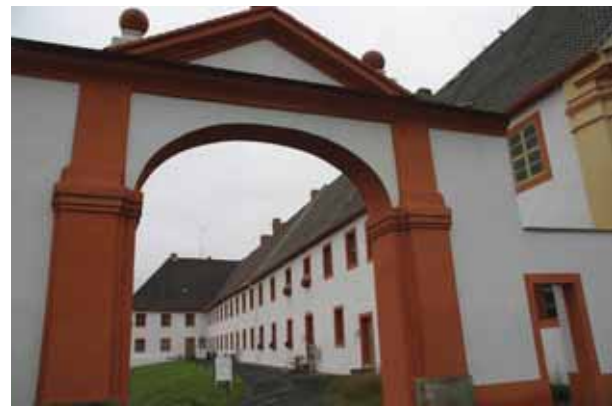
Abb. 68 Beamtenhaus, Hoffassade nach der Restaurierung
