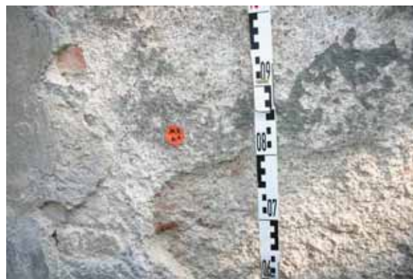
Abb. 22 Beamtenhaus, Nordwestfassade, M_K_M1
