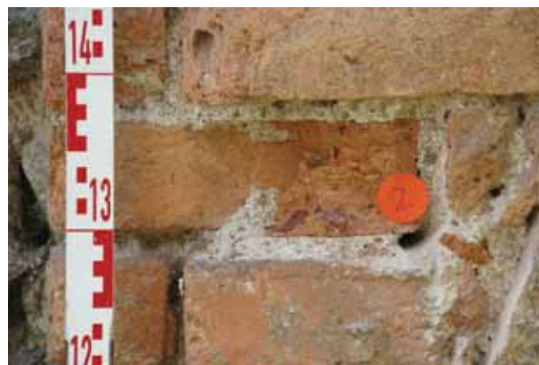
Abb. 28 Beamtenhaus, Giebel, Pilaster, Tiefenprofil MKG_TP1_2/
