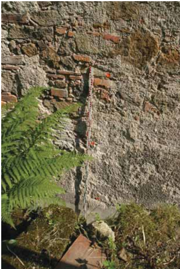
Abb. 8 Beamtenhaus, Nordwestfassade, M_K_TP3
