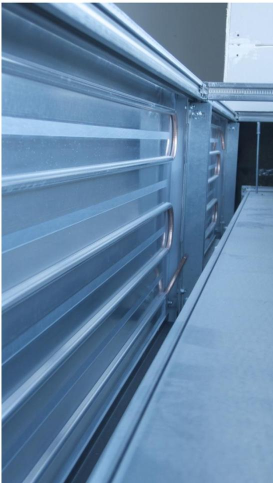
Abbildung 20: Foto Wandheizelement des Brüstungselements (ohne Abdeckung)
