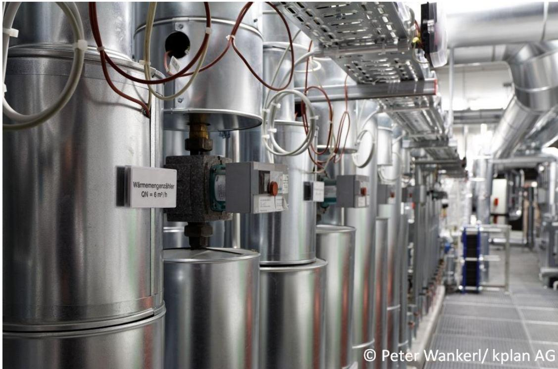
Abbildung 12: Wärmeverteilung in der Technikzentrale
