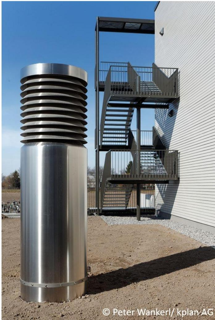
Abbildung 15: Lamellenturm zur Außenluftansaugung
