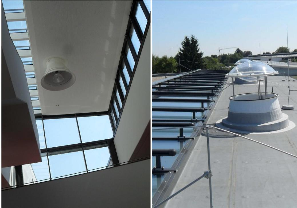
Abbildung 9: Fotos einer Kuppel im Atriumdach mit integriertem Abluftventilator
