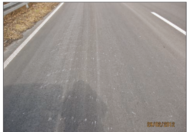
Bild 23: Solespuren im Bereich der rechten Rollspur auf der Grabener Straße, KW 09-2012, Karlsruhe
