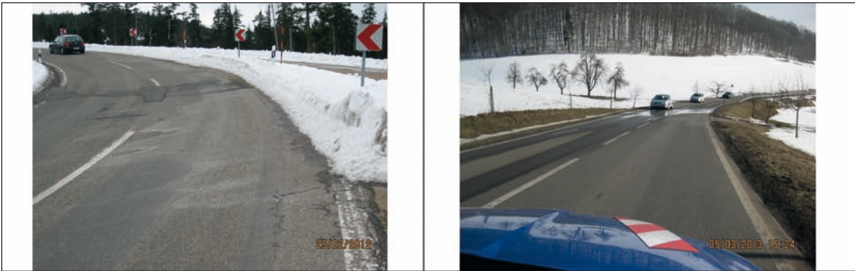
Bild 150: Angetrockneter Salzfilm auf der Fahrbahn durch geschmolzenen Schneematsch, der über die Fahrbahn gelaufen ist, L66b_b, Gernsbach
