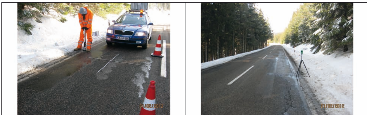
Bild 75: Unterschiedliche Fahrbahnzustände aufgrund von Schneematsch und Sonneneinstrahlung, 21.02.2012, L66b_c, Gernsbach
