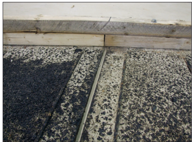
Bild 33: Seitliche Schalung
