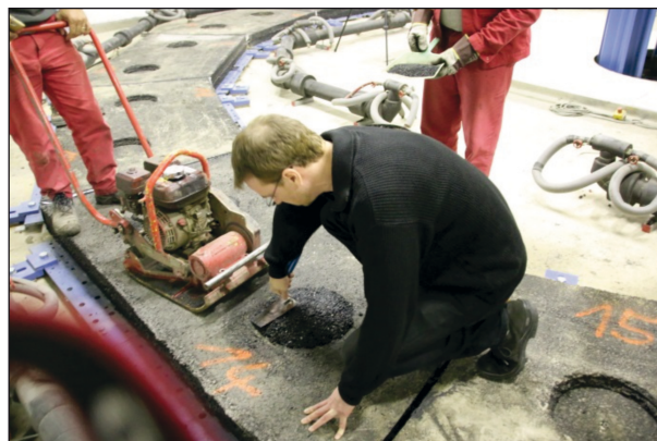
Bild 40: Einbau der Sanierungsmaterialien
