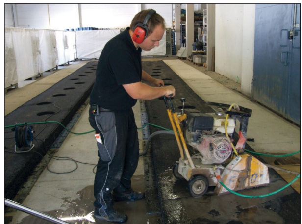
Bild 38: Schneiden der Fahrbahnplatten
