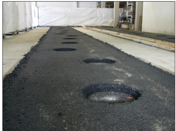
Bild 37: Fahrbahnplatten mit Musterschlaglöchern
