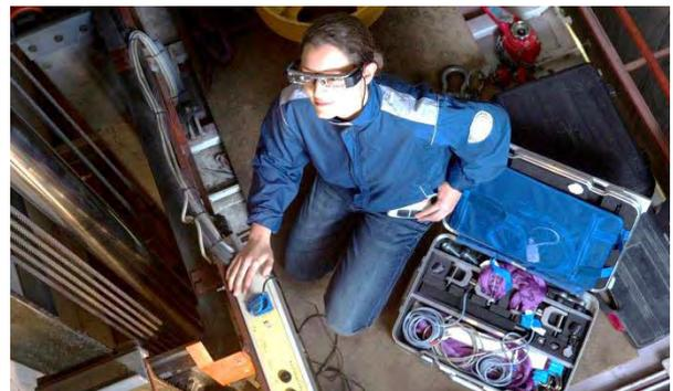
Abbildung 3: Einsatz des CyberInspection-Systems bei der Instandhaltung. (Quelle: [5], © Dirk Mahler)
