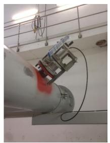
Abbildung 16: Feststoffsonde APW-Schmarl, Abwasser nach links fließend zur ZKA-Rostock
