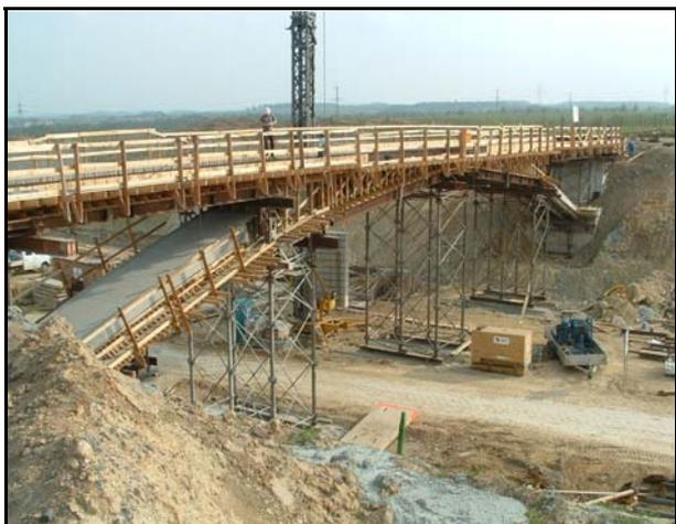
**Bild 23:** Trennung von Überbau und Bogen. Schalung des Überbaus über den fertigen Bogenstielen
