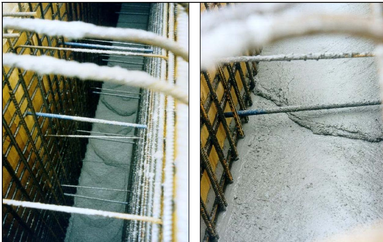
**Bild 4:** Fließverhalten des Frischbetons in der Schalung
