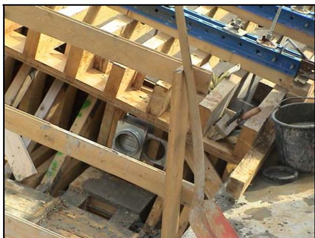
**Bild 29:** Einfüllstützen mit Schieber
