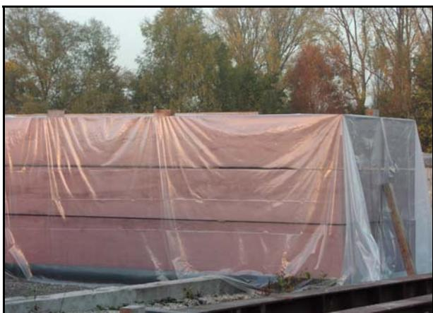
**Bild 17:** Nachbehandlung bis zum Betonalter von 7 Tagen
