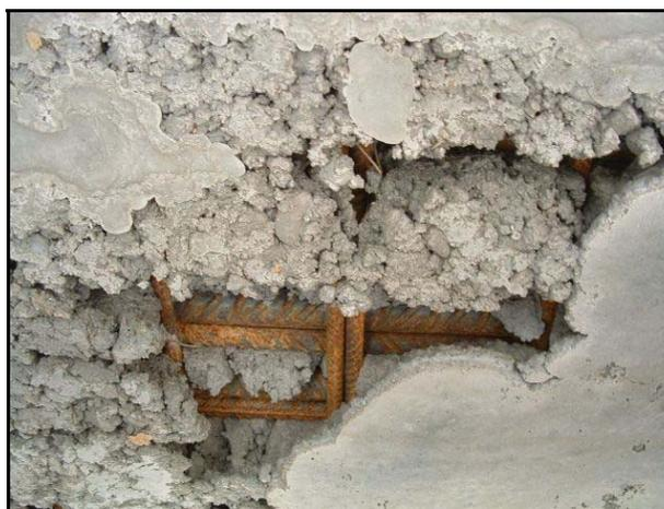
**Bild 31:** Untersicht des Festbetons im 2. Bogenstiel mit Blick auf die freiliegende Bewehrung
