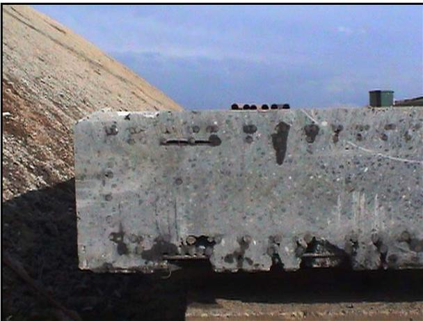
**Bild 33:** Sägeschnitt durch den Bogen. Oben links ist ein Luftporen an der oberen Bewehrung sichtbar, an der Unterseite die freiliegende Bewehrung
