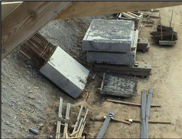
**Bild 32:** Zweiter Bogenstiel nach dem Rückbau. Links im Bild der oberste Teil mit der Anschlussbewehrung für den Überbau. Vorne unten der Rest nach Freilegen der Anschlussbewehrung des Betongelenks zwischen Widerlager und Bogenfuß
