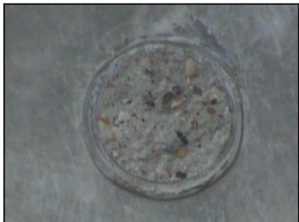
**Bild 35:** Sichtbeton am Einfüllstutzen
