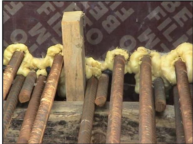
**Bild 27:** Abdichtung der Anschlussbewehrung am Hochpunkt
