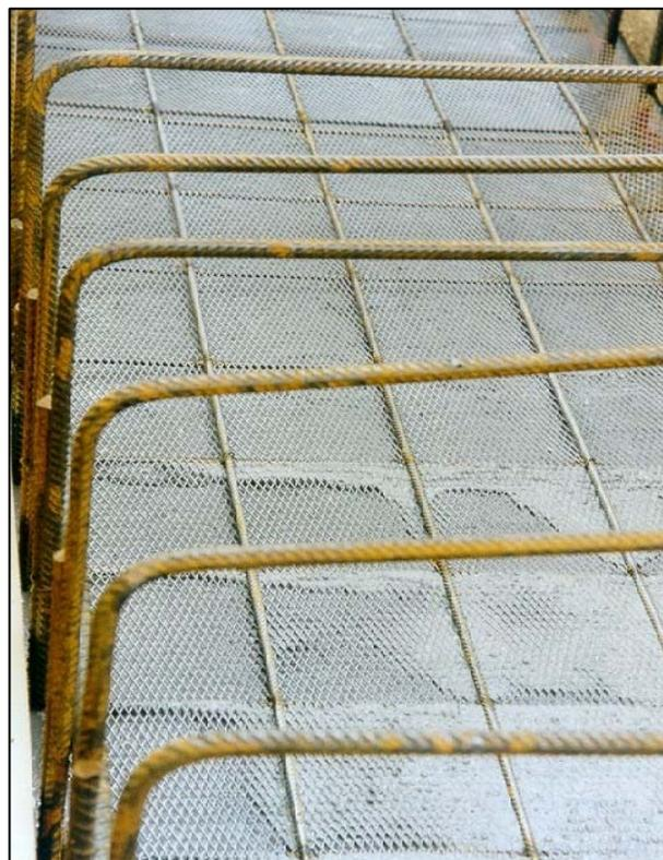
**Bild 6:** Herstellen der Oberflächenneigung von 2.7 %
