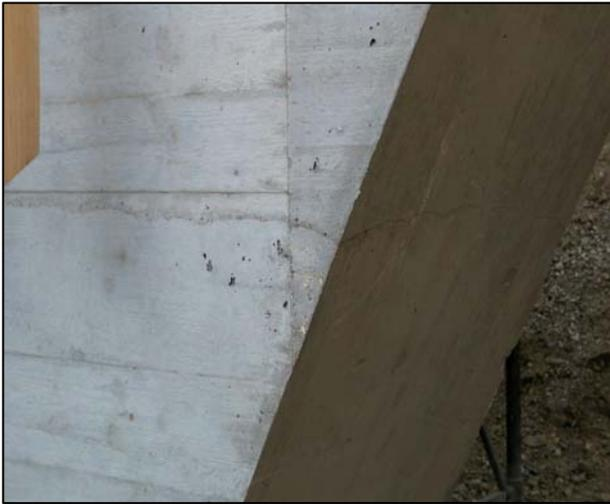
**Bild 12:** Sauber gebrochene Kanten, kleine Mörtelwülste und Luftporen
