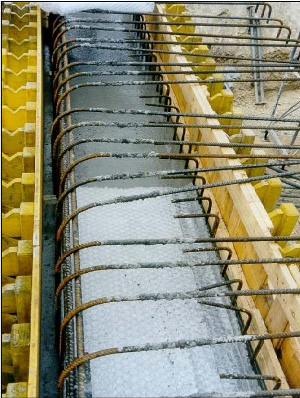
**Bild 7:** Wärmedämmung der freien Oberfläche
