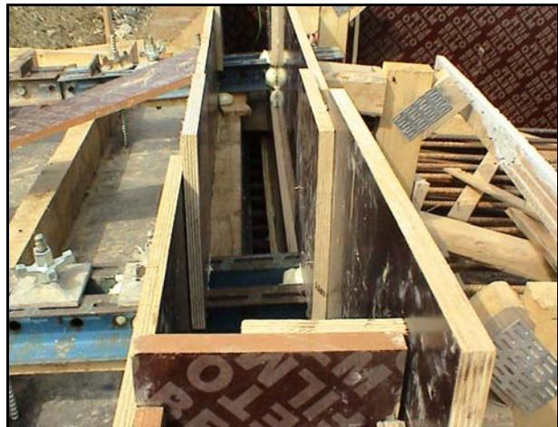
**Bild 28:** Schalungsaufsatz am Hochpunkt der Bogenschalung (Betoniertrichter)
