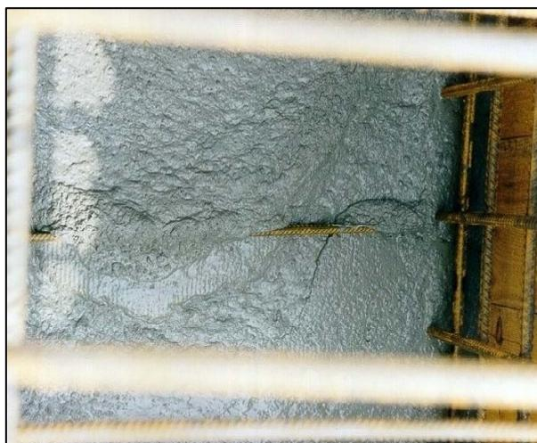
**Bild 5:** Vollständige Umhüllung der Bewehrung durch den SVB
