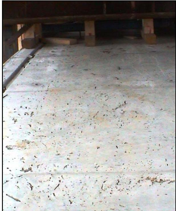
**Bild 34:** Bild der Laufspuren der aufsteigenden Luft an der Deckenschalung auf der Bogenoberseite
