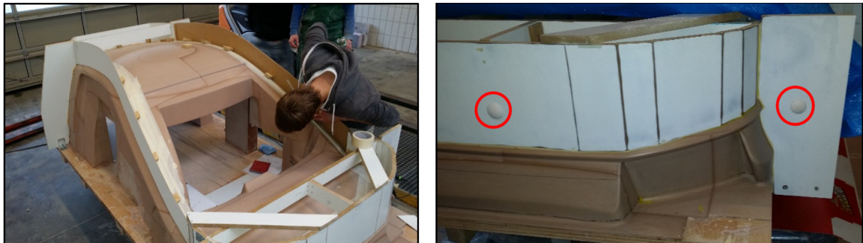
Abbildung 20: Montage der Trennebenen und Zentrierhilfen
