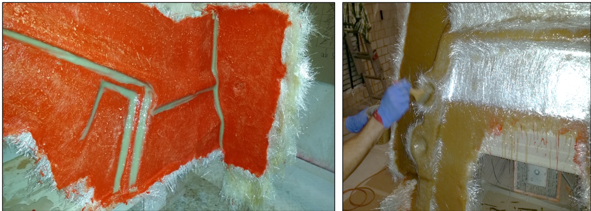
Abbildung 22: Eckverstärkungen mit Bonding paste und Laminieren der Glasfaserlagen
