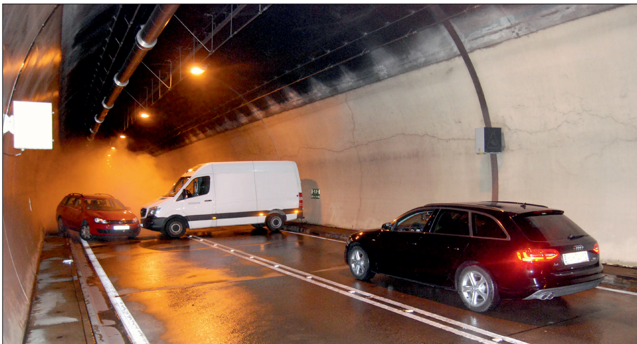
Bild 10: Situation im Tunnel, in dem Moment, in dem die BBA eingeschaltet wird. Das schwarze Fahrzeug ist das angekommene Probandenfahrzeug.
