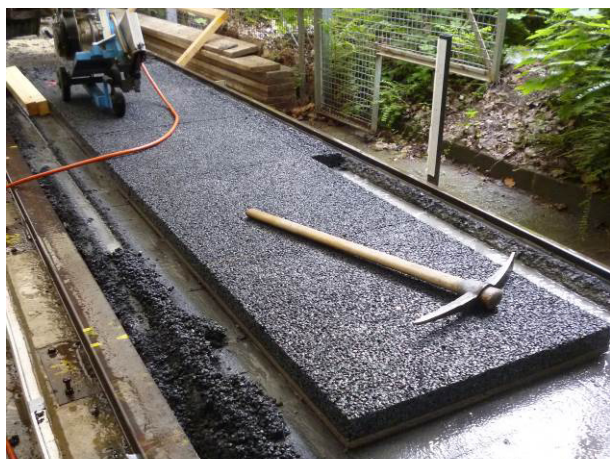
Bild 13: Entnahme der großformatigen Asphaltplatten mitsamt Holzunterlage
