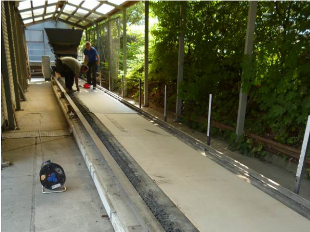
Bild 7: Aufbringen der Holzunterlage auf einer bestehenden Asphalt-schicht
