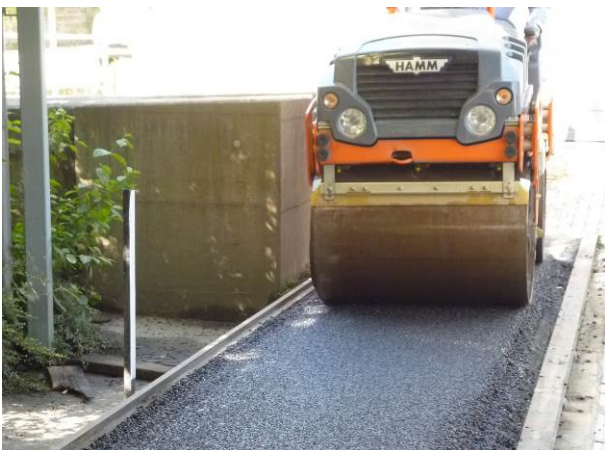
Bild 11: Abschließende Walzverdichtung (statisch)
