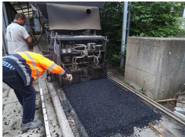
Bild 10: Kontrolle der Schichtdicke während des Einbauprozesses
