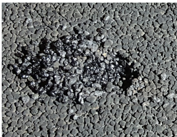
Bild 74: Manueller Aufbruch der Versuchsplatte nach Brandversuchsende (PA 2, P4)
