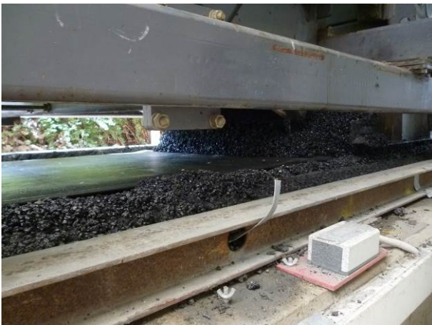
Bild 9: Einbau des Mischguts PA 8 mittels Spezialfertiger
