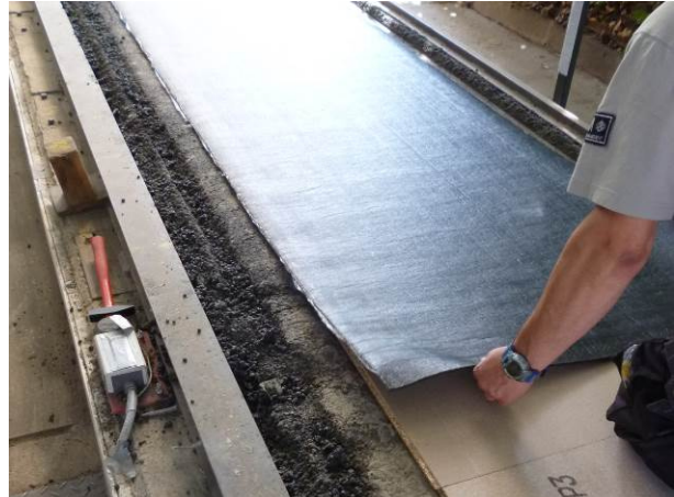
Bild 8: Verlegung der Bitumenbahn auf der Holzunterlage
