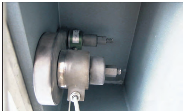
Bild 22: Kraftmessdosen an der Kappenanschlussbewehrung
