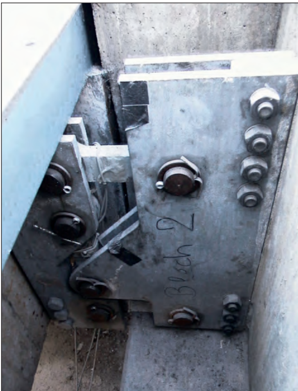
Bild 21: Augenstäbe der Konsolaufhängung mit Dehnungsmessstreifen
