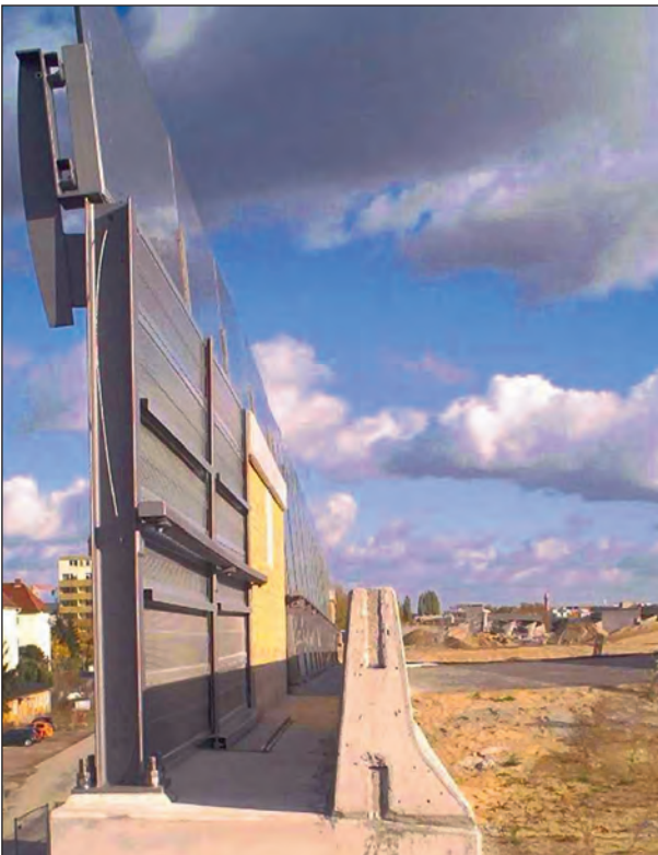
Bild 8: Ausführung einer Betonschutzwand aus Fertigteilen vor einer Lärmschutzwand analog Richtzeichnung Kap 1
