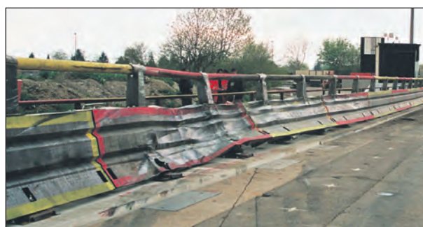
Bild 47: System F: Kontaktstrecke nach Prüfung TB 81 mit Systemschäden
