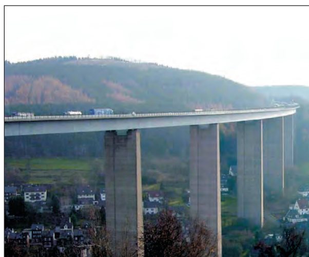
Bild 1: Dichte Bebauung unterhalb einer Talbrücke
