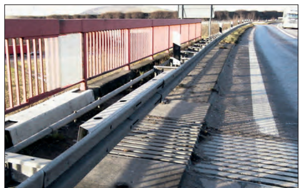
Bild 10: Ausführung eines Dilatationsstoßes bei einer Einfachen Distanzschutzplanke
