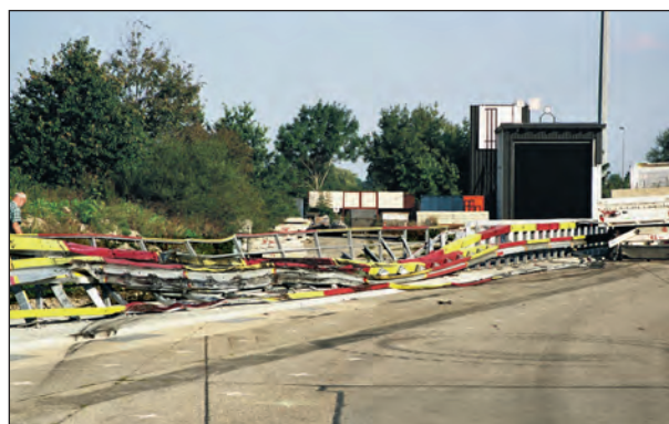
Bild 27: System B: Kontaktstrecke nach Prüfung TB 81 mit Systemschäden
