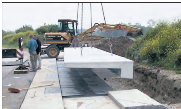
Bild 17: Einheben der 12-m-Kappe
