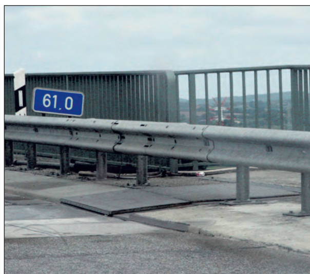
Bild 8: Ausführung eines Dilatationsstoßes bei einer Einfachen Distanzschutzplanke
