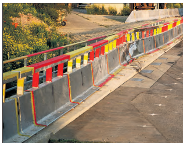
Bild 37: System D: Kontaktstrecke nach Prüfung TB 81 mit Systemschäden
