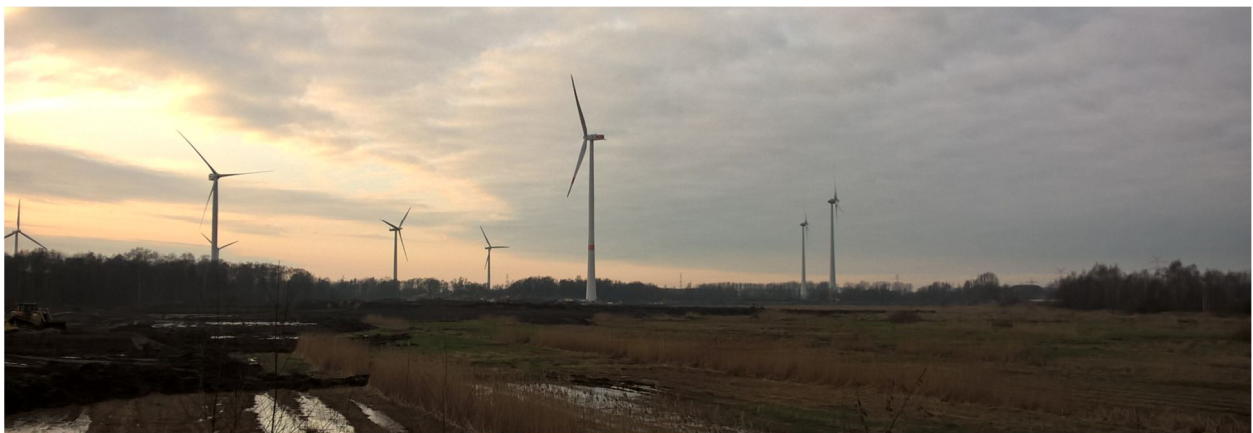
Abbildung 13 SENVION 3.4M104 Windenergieanlage bei den Bremer Stahlwerken
